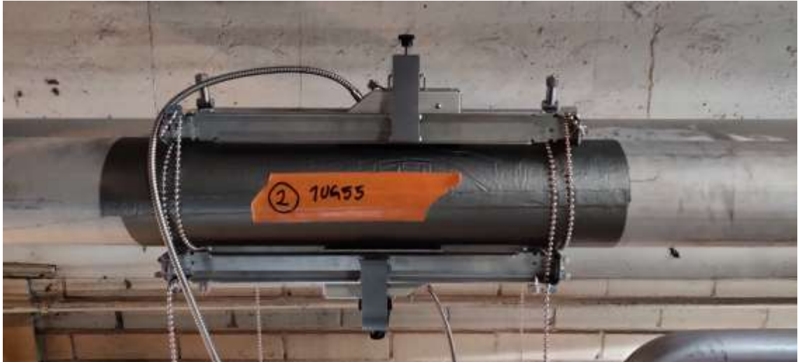
Kuva 9. GSK-mittausantureiden kiinnitys VARIOFIX-kiskoilla mittauspisteessä 2.
