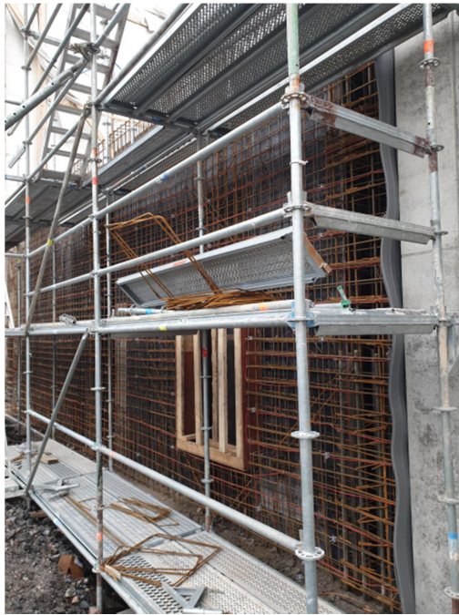
Kuva 4. Muottien ensimmäisen sivun jälkeen tehtiin raudoitus (Tarvainen 2020).
