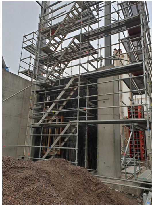
Kuva 6. Valutyöt jouduttiin toteuttamaan telineiltä käsin (Tarvainen 2020).
