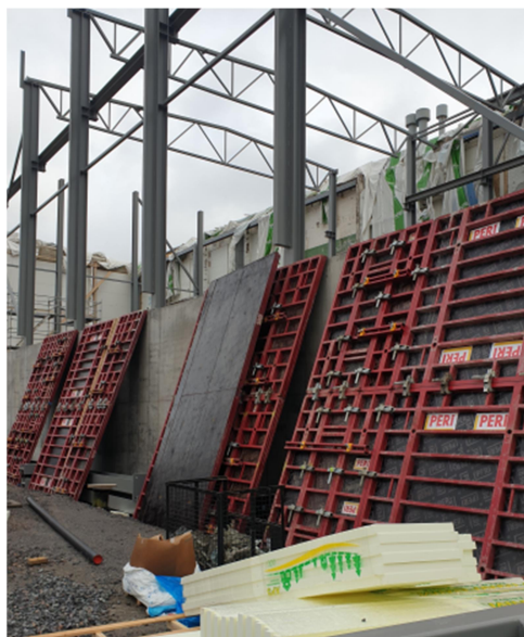
Kuva 7. Muotit olivat hyvin kookkaita ja painavia, nostoon tarvittiin apuvälineitä (Tarvainen 2020).
