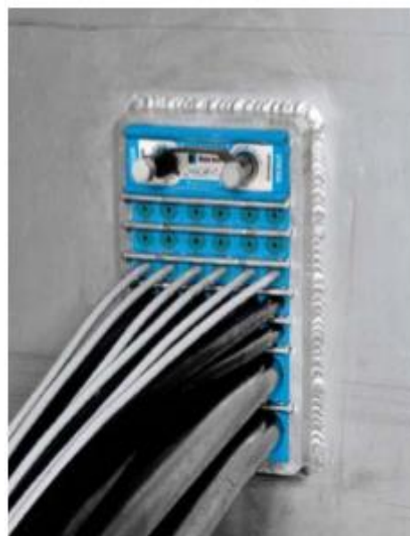
Kuva 6. Roxtec-kaapeliläpivienti
