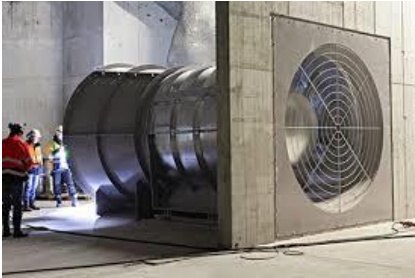
Kuva 2. Länsimetron savunpoistopuhallin /10/.
