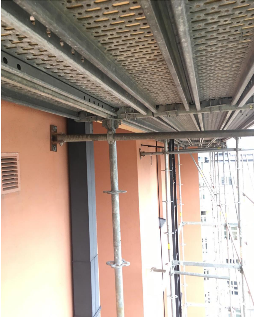
Kuva 3. PERI Suomi Ltd Oy:n telinekohde Helsingissä. Ylimpänä ankkurina käytössä lattate-räsankkuri.
