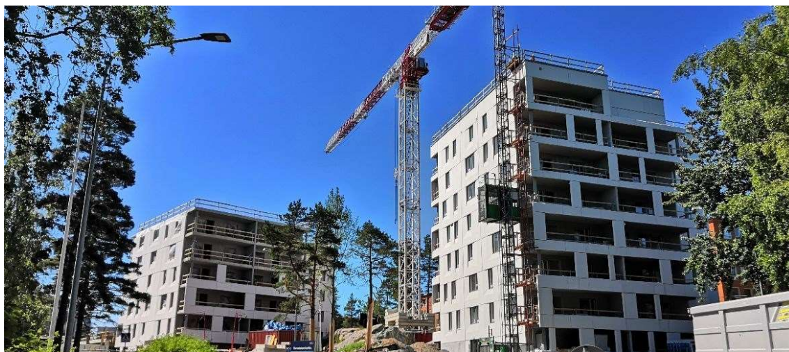
Kuva 6. NCC rakentaa kolmea Haso-kerrostaloa Helsingin Laajasaloon. [10.]
