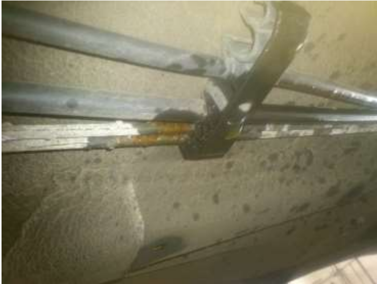
Kuva 58. Jarruputket hapettuneet ja vuotaa kiinnikkeen kohdalta (25).
