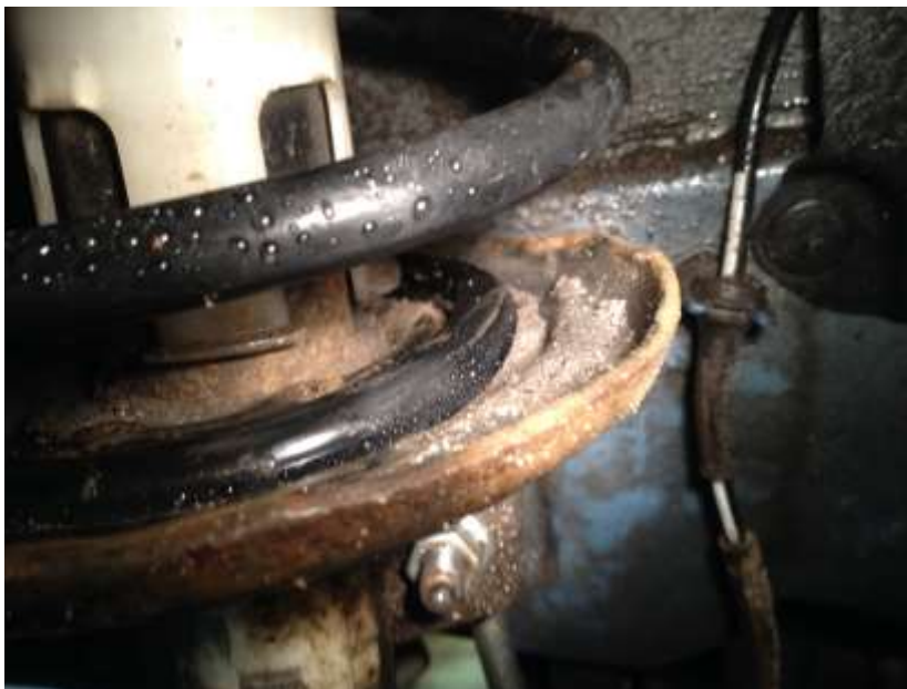
Kuva 25. Asennusvirhe; jousi ylösalaisin. Jousen alapää lähempää kuvattuna.
