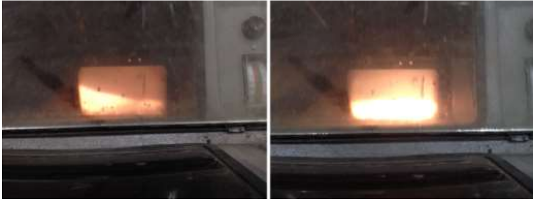
Kuva 15. Virheellisesti asennettu polttimo. Kuva 16. Oikein asennettu polttimo.
