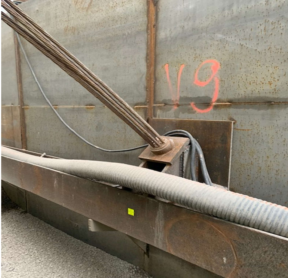
Kuva 5. Settiseinän tuenta kallioankkurilla
