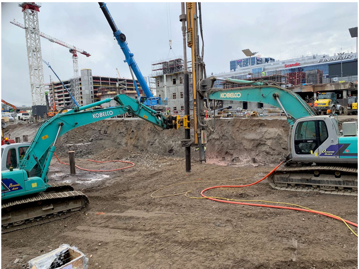
Kuva 8. Apukone nostaa paalun pystysuorana poravaunuun
