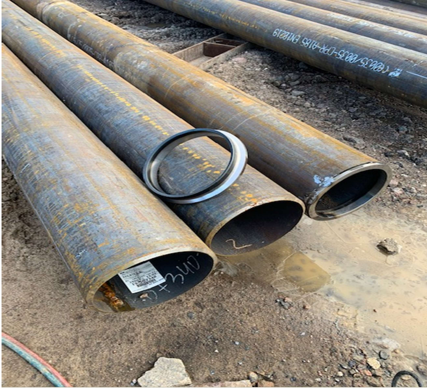
Kuva 6. Paaluun hitsattava maakenkä
