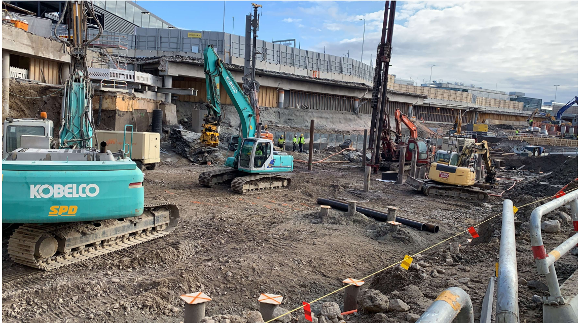
Kuva 10. Paalutuskoneiden sijoittaminen työmaalle
