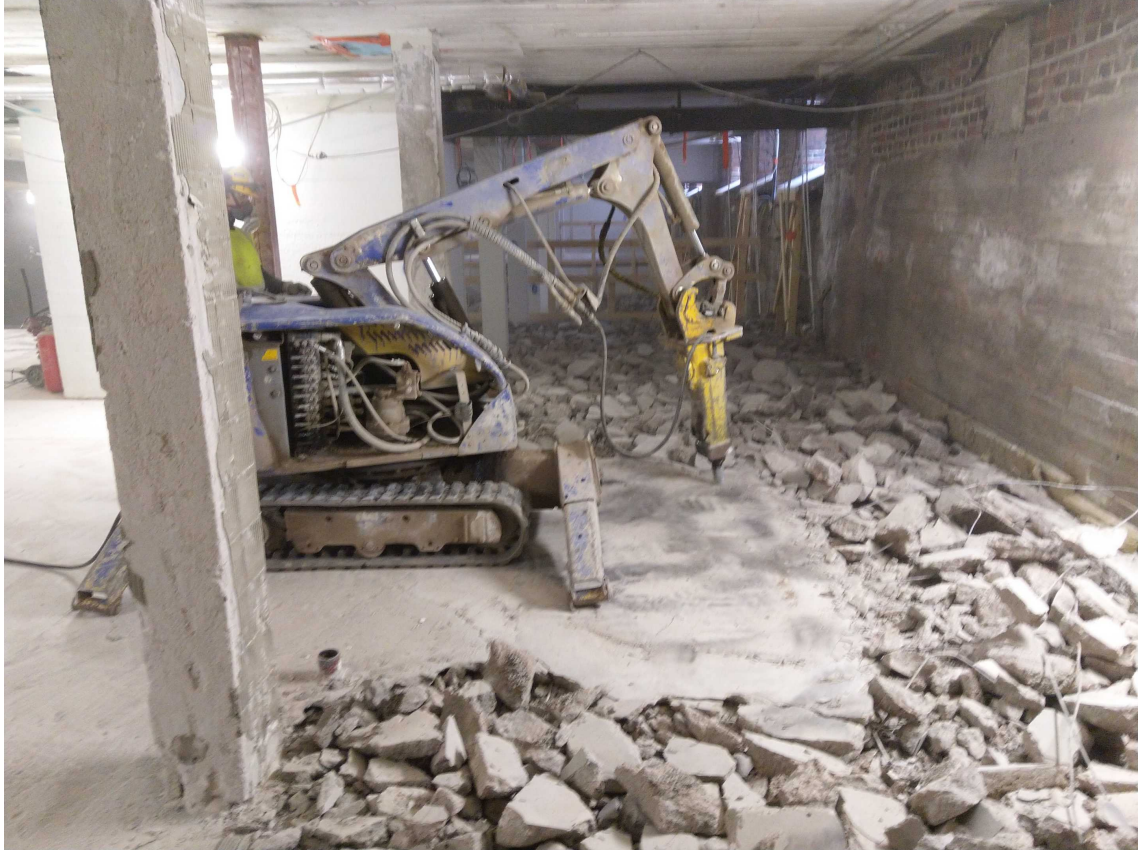
Kuva 2. Teräsbetoni-laatan purkutöissä käytettiin Brok-piikkausrobottia. (Kuusimäki 2019.)
