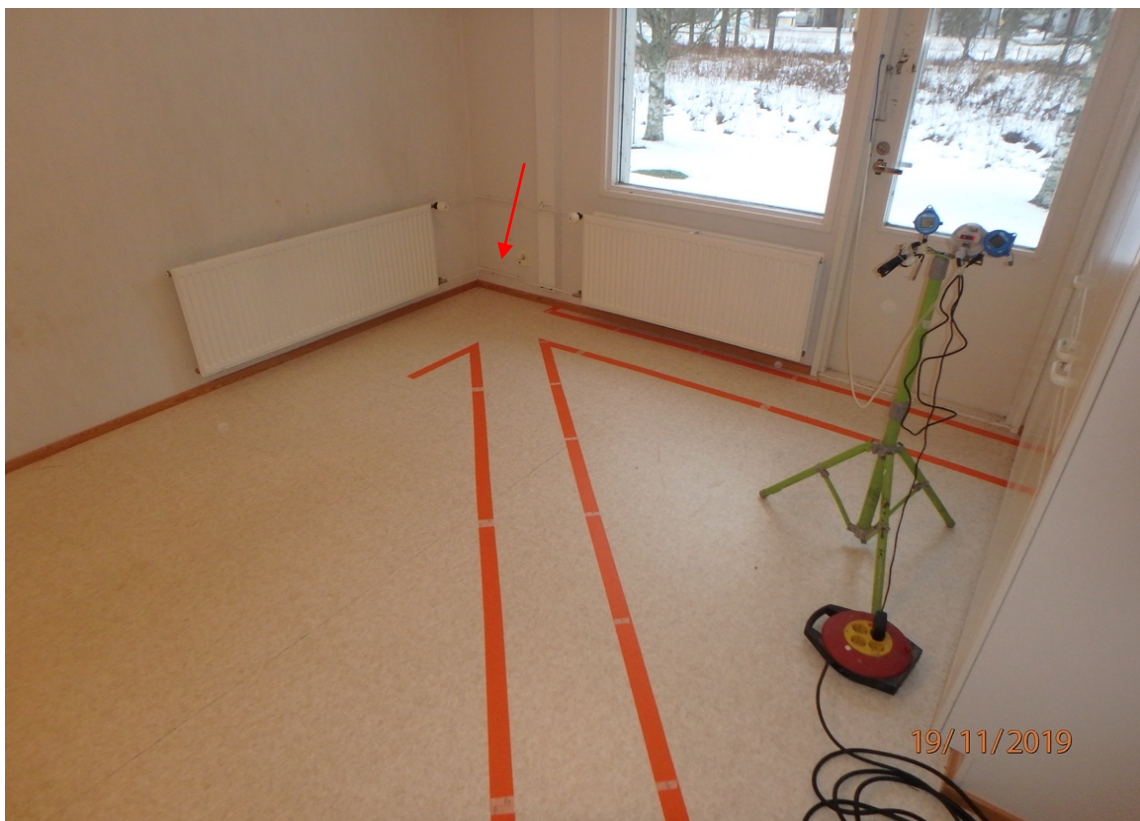
KUVA 38. Testihuoneen lattiaan rajattu "pölyrata". Rakenneavauskohhta ulkonurkassa nuolen osoittamalla kohdalla. (Meriläinen 2019)
