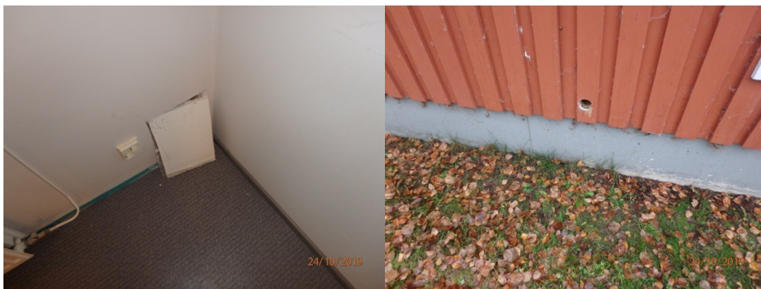
KUVA 12. ja KUVA 13. Vasemman puoleisessa kuvassa seinän alaosaan tehty rakenneavaus. Oikean puoleisessa kuvassa savukoneen asennusreikä. (Meriläinen 2019)
