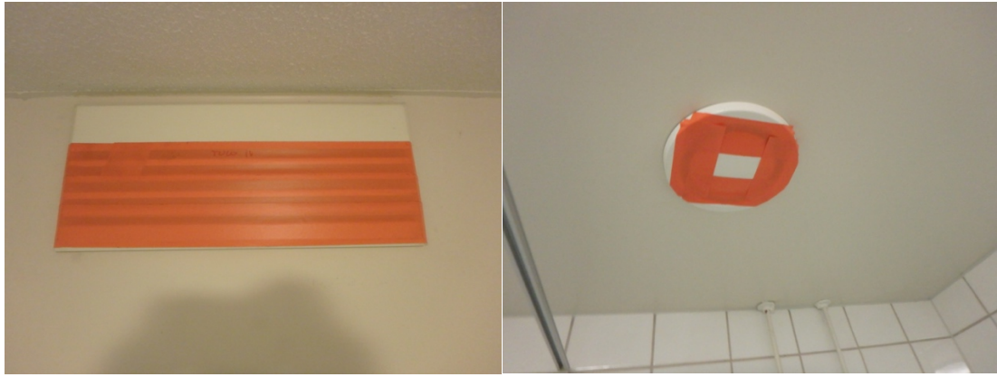
KUVA 8. ja KUVA 9. Tilan tulo- ja poistoilmaventtiilit suljettiin teipillä. (Meriläinen 2019)
