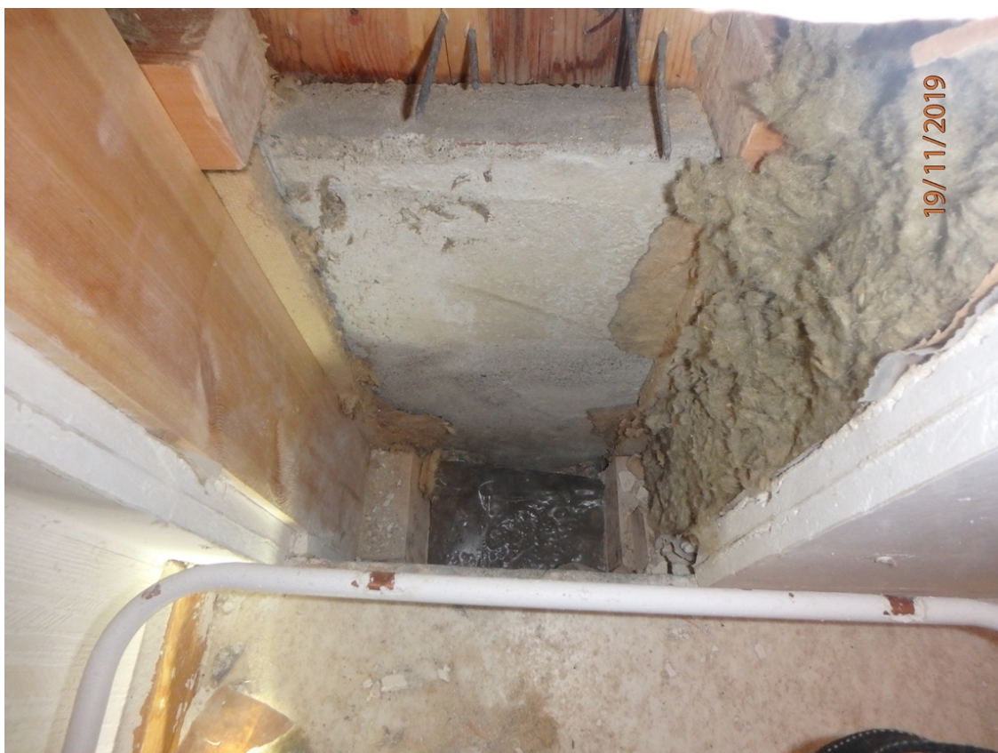
KUVA 39. Kuva rakenneavauksesta. Rakenne avattiin "normaaliin" tapaan niin, että rakenne saadaan täysin selvitettyä, rakenneavauksen kesto oli n. 33min. (Meriläinen 2019)
