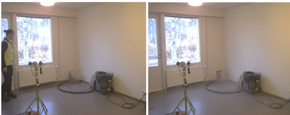
KUVA 34. ja KUVA 35. Vasemman puoleisessa kuvassa lähtötilanne n. 20 Pa alipaineessa. Oikean puoleisessa kuvassa savu levinnyt lähes koko tilan alalle, savu vaikeasti havaittavaa, aikaa on alkutilanteesta kulunut 15 s. (Meriläinen 2019)
