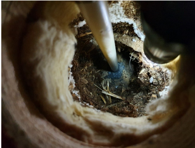
Kuva 16. Rakenneavauskohtaan on asennettu betonilaatan suhteellisen kosteuden mittaputki.
