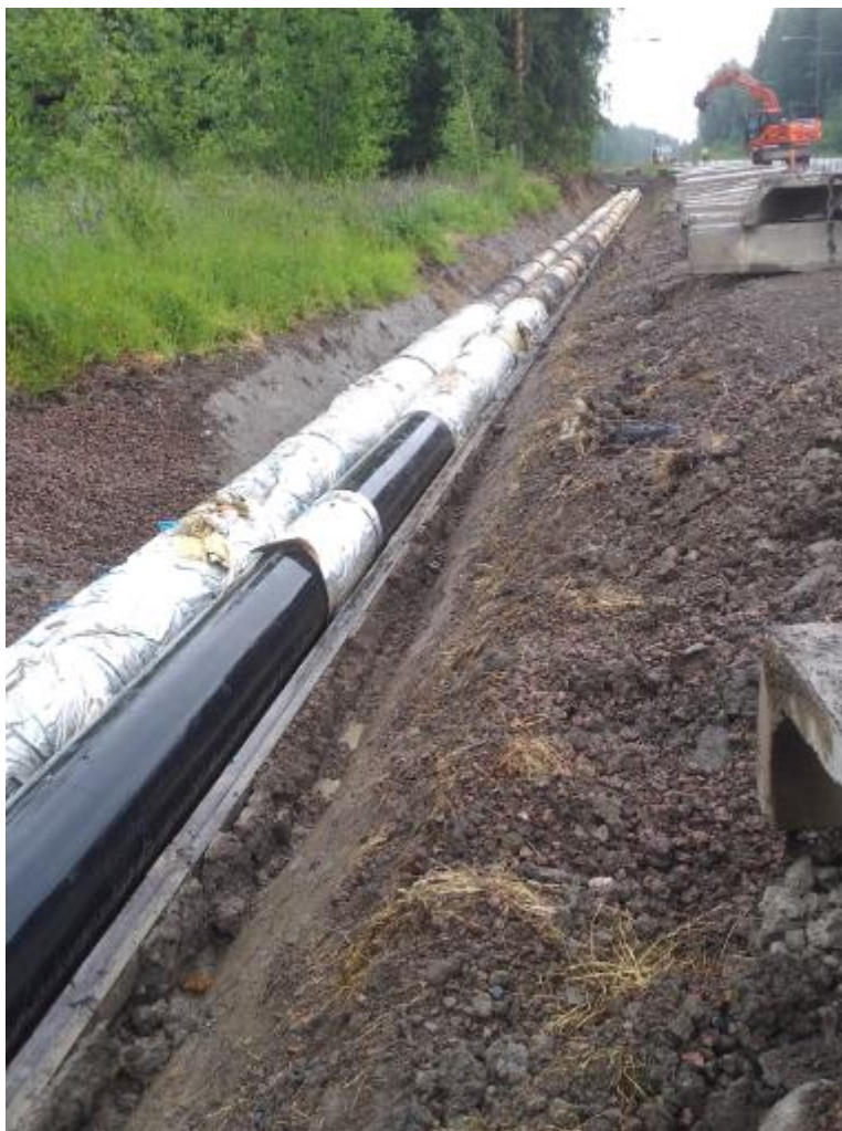
Bild 3: Foto på en öppen betongkanal i vid Tolkisvägen i Borgå.
