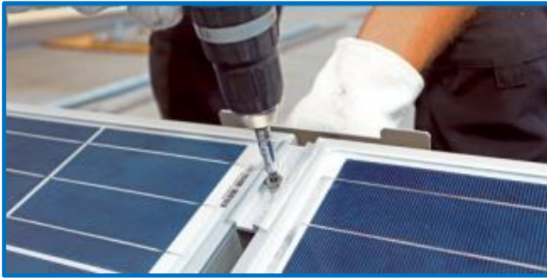
KUVA 6. Tarkastetaan aurinkopaneelin kiinnitys (12.)
