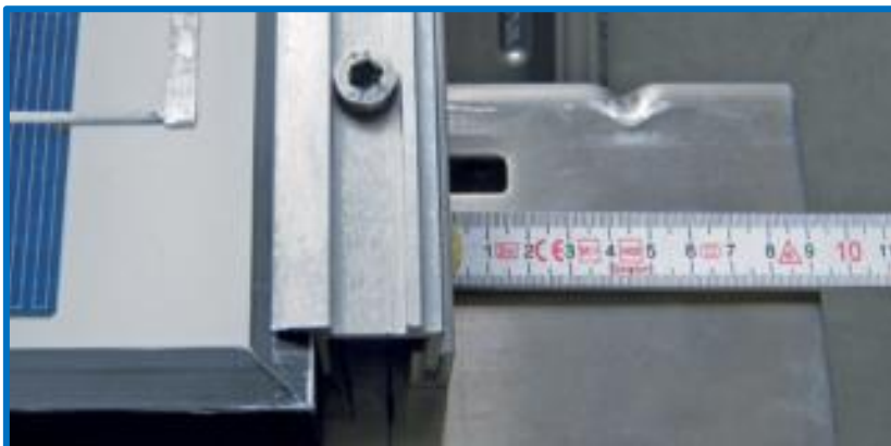
KUVA 7. Tarkistetaan, päätykiinnikkeen etäisyys kattojalan reunasta, ettei paneelikenttä ole liikkunut (12).
