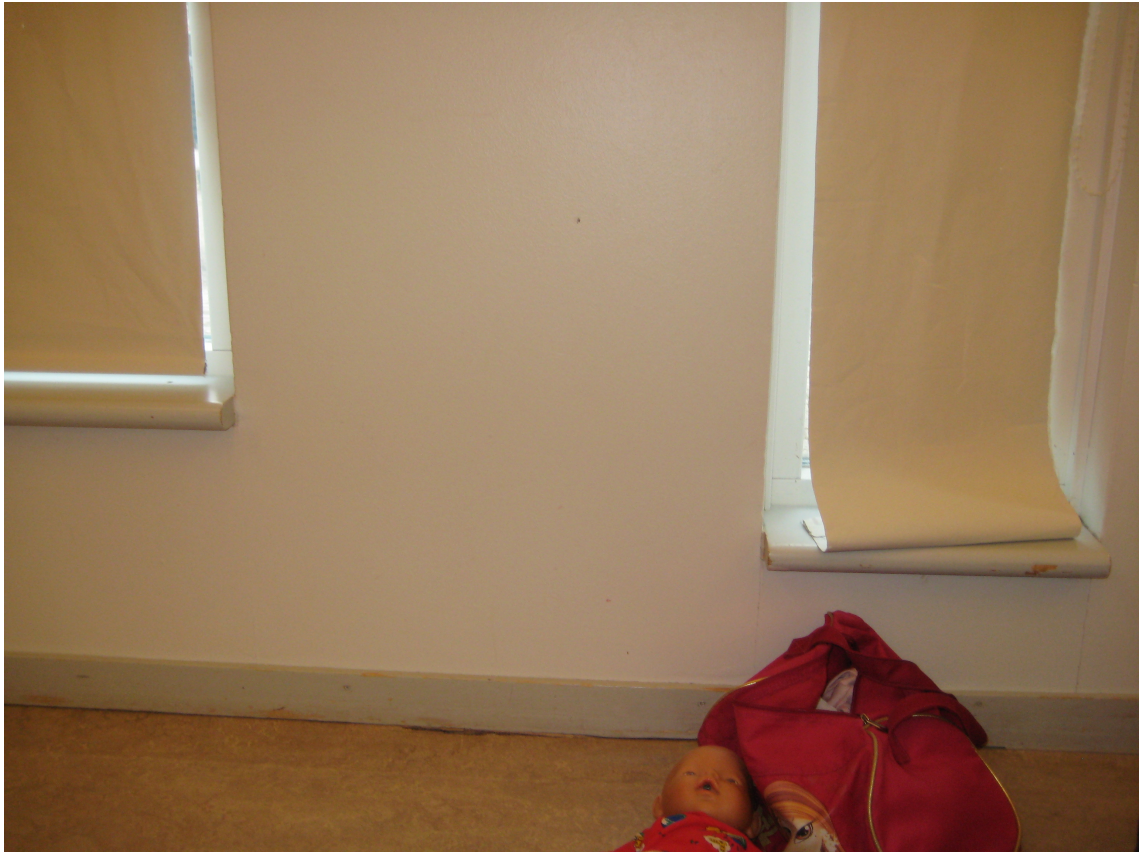
Kuva 5. Friisilän päiväkodin liikuntasalin ikkunoita.
