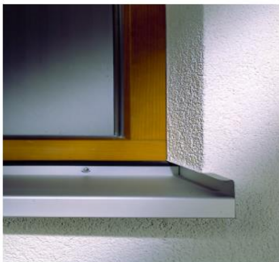
Kuva 26. Valmis ikkunaliitos (Alseccofinland.fi b)
