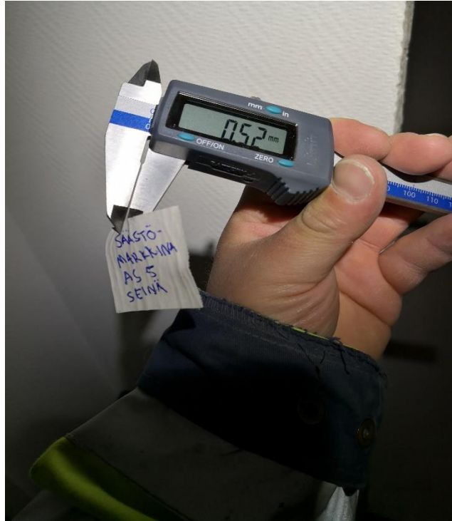
Kuva 4. Vedeneristeen kalvovahvuuden mittaus
