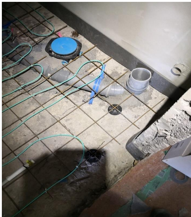
Kuva 3. Kph lattia valukunnossa
