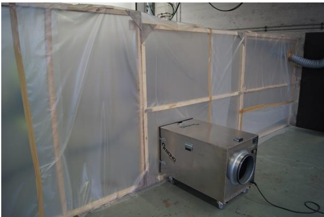
Kuva 5. Työtilan osastointi ja alipaineistus. /19/
