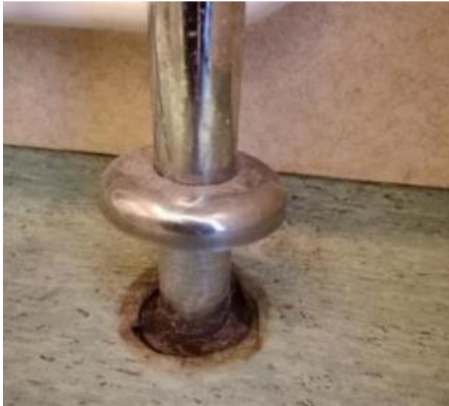
Kuva 35. Käsienvesualtaan viemäriputken läpivienti.
