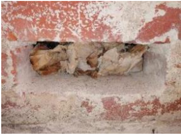
Kuva 46. Tiiliseinän ja betoniseinän välinen ilmarako.
