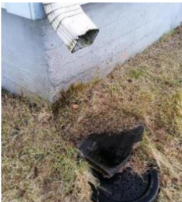
Kuva 5. Rännikaivon päällä on liuskekivi.
