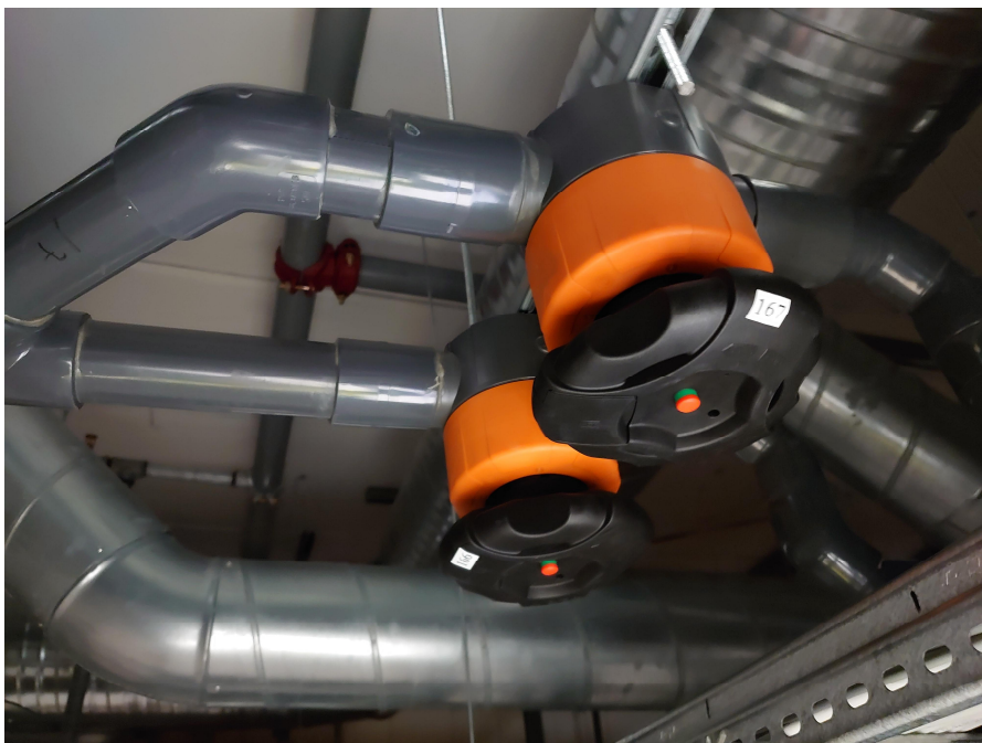
KUVA 35 Manuaaliventtiilit asennettuna alakattoon
