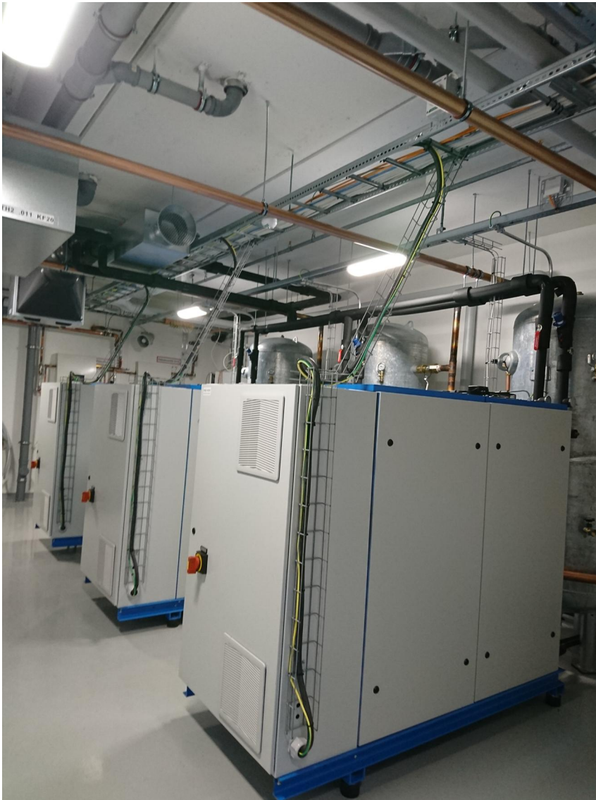
KUVA 3 Kompressorit ja paineentasaus säiliöt
