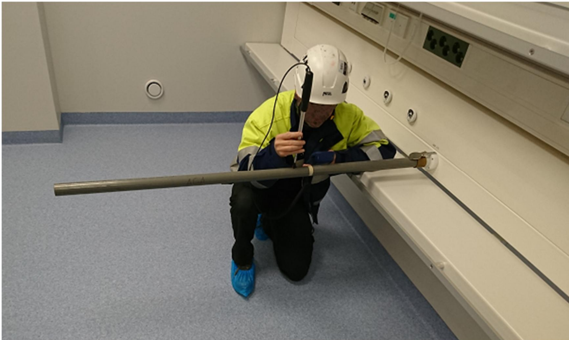
KUVA 40 Poistopisteen mittaustyö heräämössä
