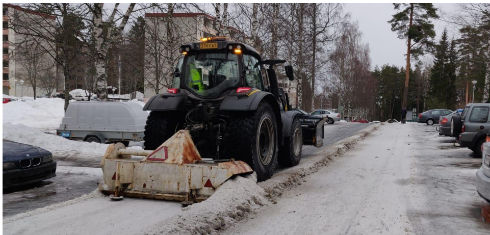
Kuva 3. Polanteen poistoa Jyrsimällä (Auvinen 2018)
