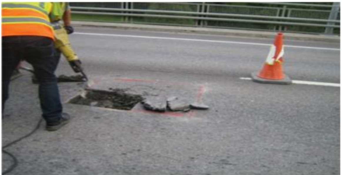
Kuva 3. Asfalttikerroksen poistoa paikattavasta eristysvauriokohdasta. (Väylävirasto 2018, 5.)
