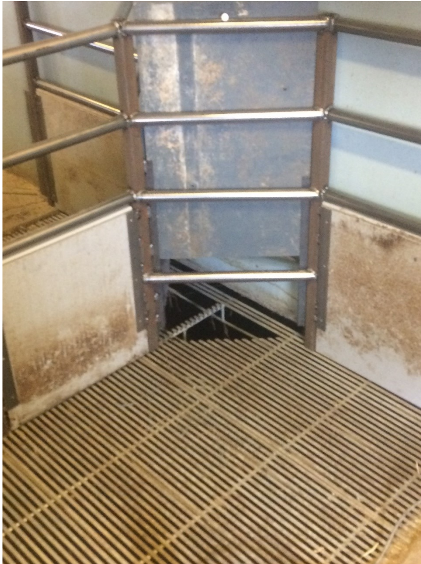
Kuva 1. Suunniteltu pudotusluukku porsituskarsinassa (Mäkitalo 2019)
