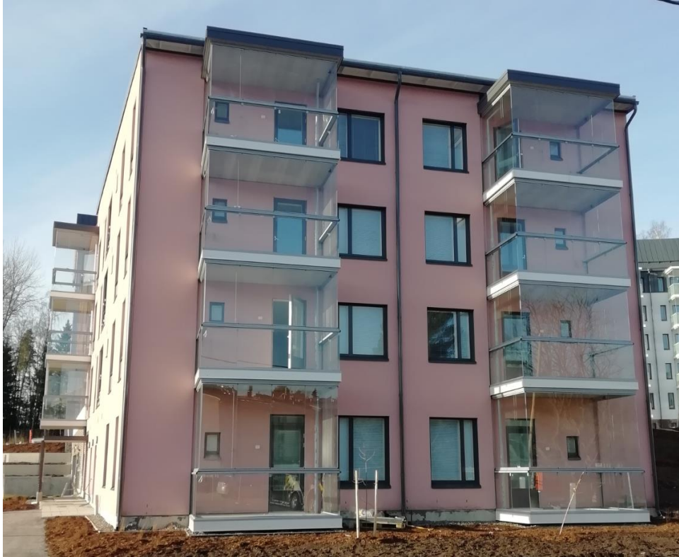
Kuva 17. As Oy Espoon Aries ulkopuolelta.
