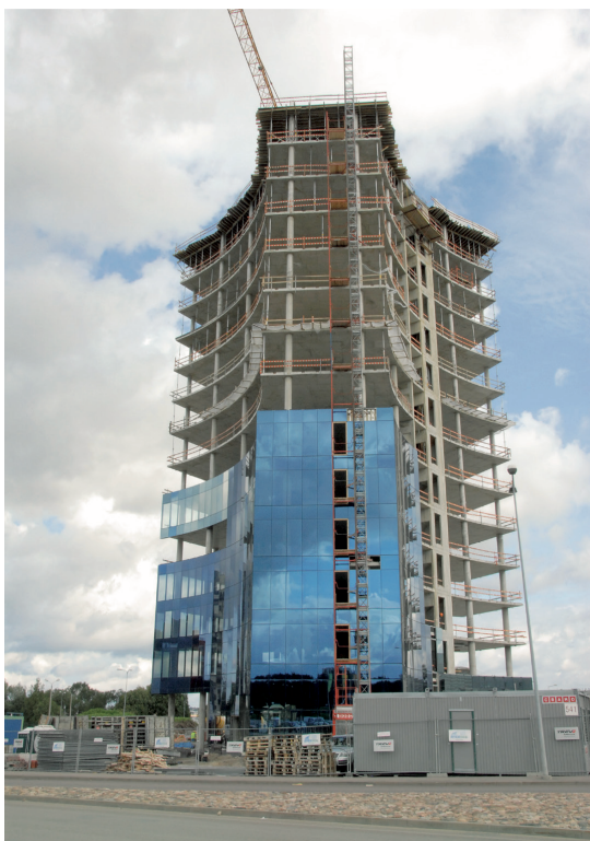
Kuva 7. Tallinnassa sijaitseva 16-kerroksinen toimistorakennus, jonka välipohjat on valettu kuitubetonilla. (Matsinen 2013)
