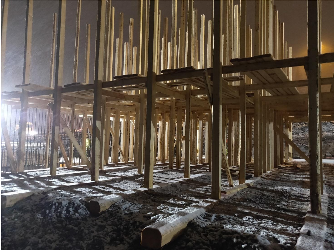
Kuva 23. Sillan telinetolpat pelkkapedin päällä
