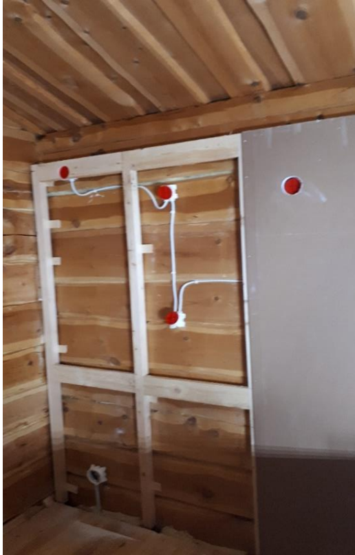
Kuva 14. Vanhan hirsiseinän koolaus ja sähkövedot kalusteille ja koneille.
