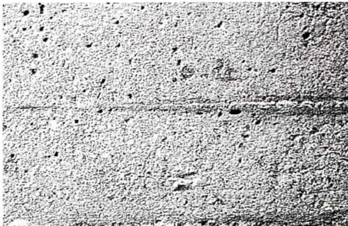
Kuva 7. Normaalisti suihkupuuhdistettu betonipinta. Siltojen korjausohjeet SILKO 1.203, 2019, 29.
