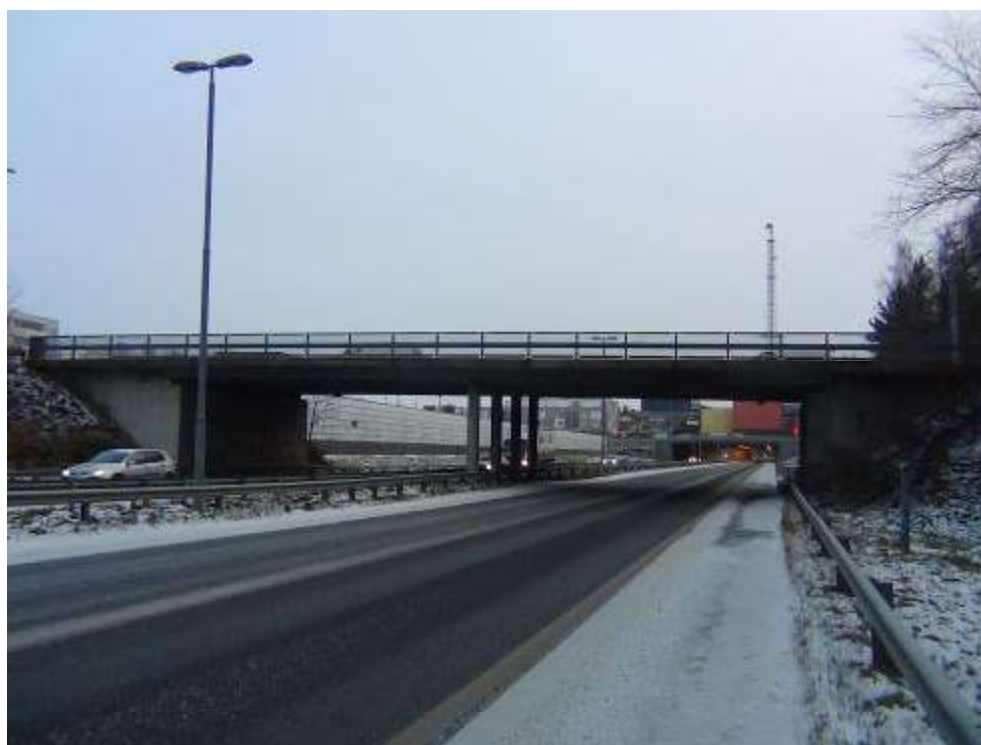
Kuva 1. Yleiskuva sillan pohjoispuolelta. Taustalla näkyy moottoritietunneli.
