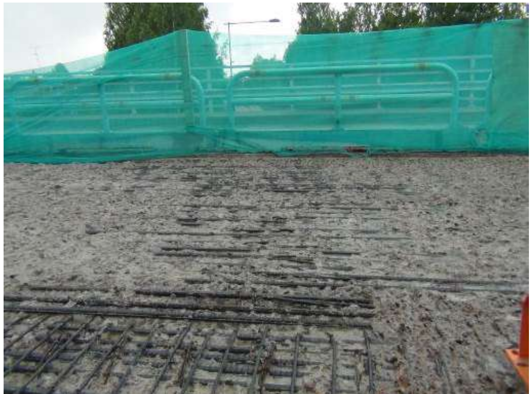
Kuva 8. Kannen yläpinnan tasovesipiikkaus löytää ”erehtymättömästi” heikoimmat kohdat. Tuloksena on karkea ja hyvä tartunta-alusta muotoiluvalulle.
