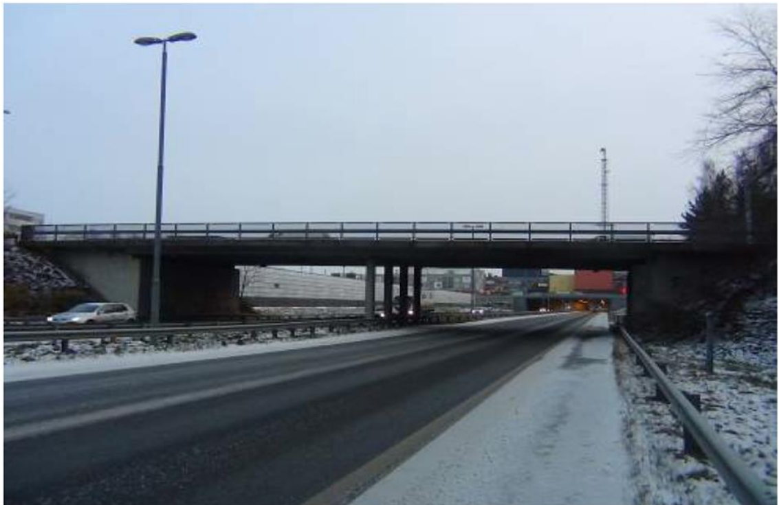
Kuva 1. Lukiokadun silta, (Erikoistarkastuksen raportti 2016)
