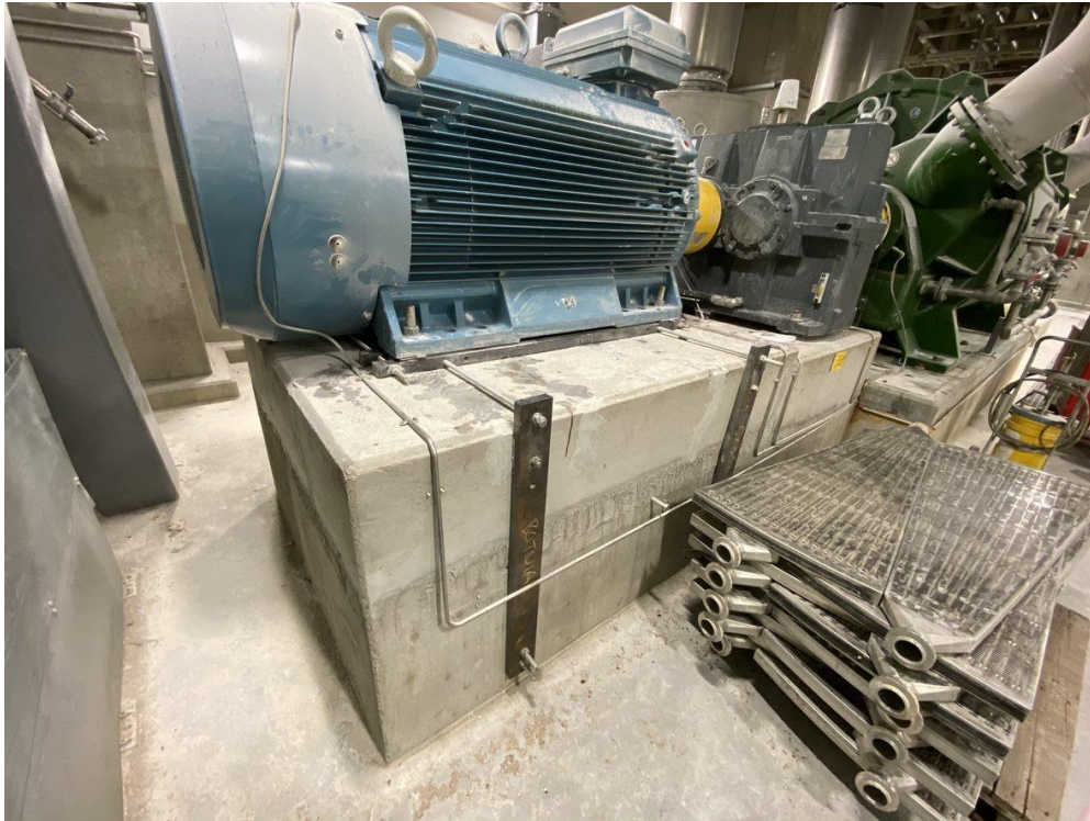
Kuva 9. Pumpun väliaikainen kiinnitys betoniperustukseen.
