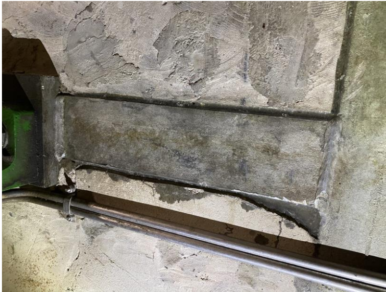
Kuva 11. Laitteen teräsrunko on kauttaaltaan injektoitu takaisin kiinni pumppuperustukseen.
