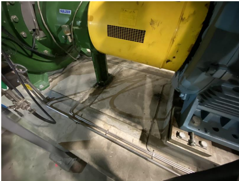
Kuva 10. Injektoimalla pumppuperustukseen takaisin kiinnitetty teräsrunko.
