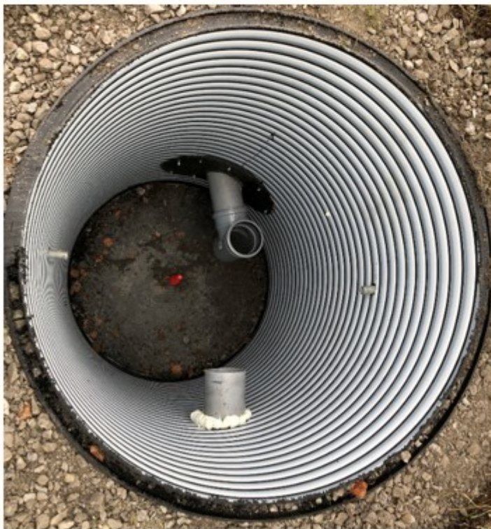
KUVA 3. Valmis kaivo (Petri Forsell, PetenPutki Oy, 2019)
