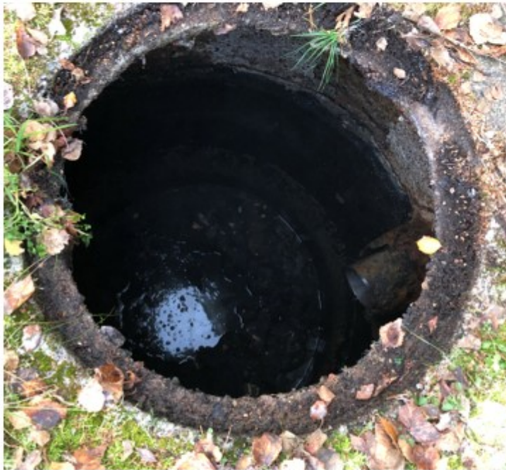
KUVA 1. Lähtötilanne (Petri Forsell, PetenPutki Oy, 2019)
