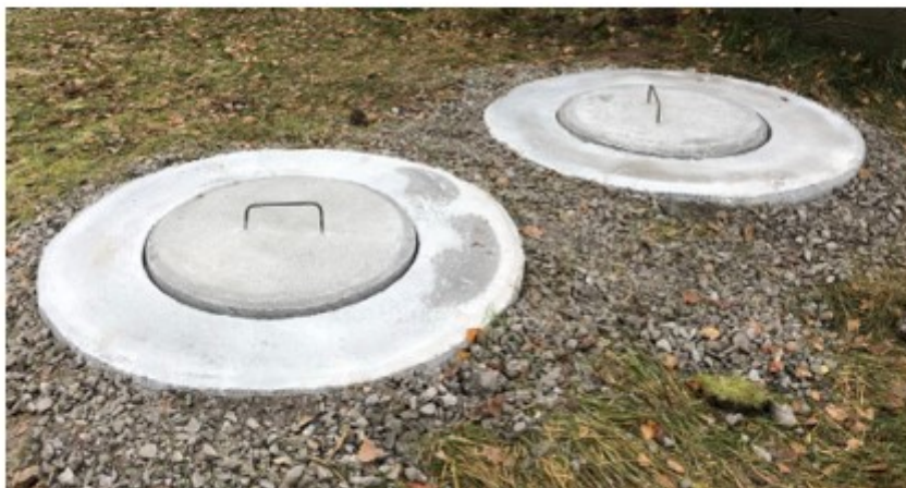
KUVA 4. Valmiit kaivot (Petri Forsell, PetenPutki Oy, 2019)
