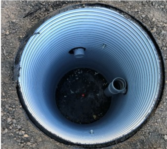
KUVA 2. Kaivo käyttö valmiina (Petri Forsell, PetenPutki Oy, 2019)
