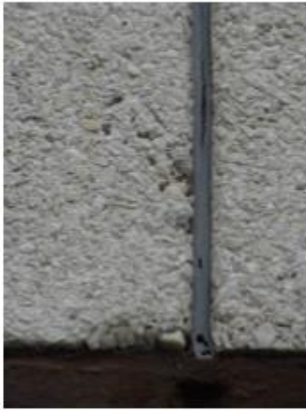
Kuva 21. Huonokuntoisia elementtisaumoja [3, s30.]
