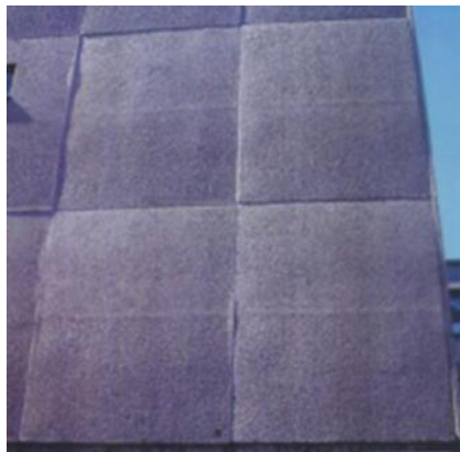
Kuva 9. Pakkasrapautuman eteneminen betonisandwichseinän ulkokuoressa. [3, s. 19.]
