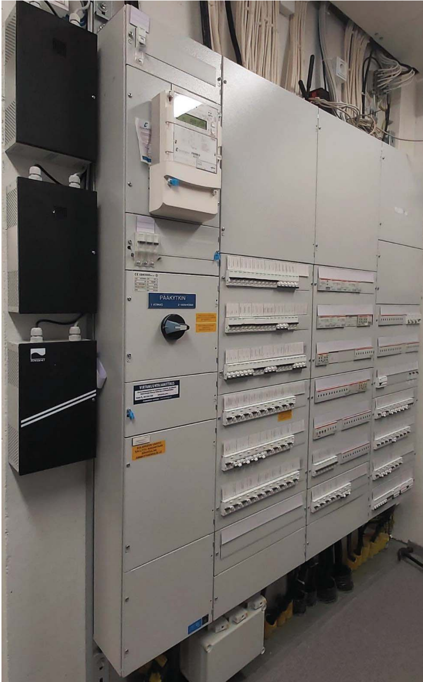
KUVA 3. Kohteen sähköpääkeskus
