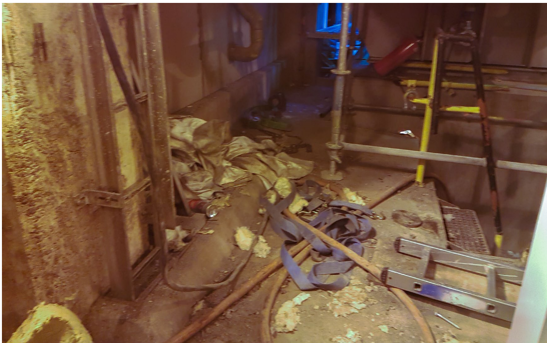
Kuvio 7. Yleinen järjestys ja siisteys työkohteessa ei täyty tässä tapauksessa. Kulkureitit ja tavarat pitää olla järjestyksessä joka päivä töiden jälkeen, jolloin myös seuraavan päivän työt lähtevät käyntiin ripeästi ja turvallisesti.
