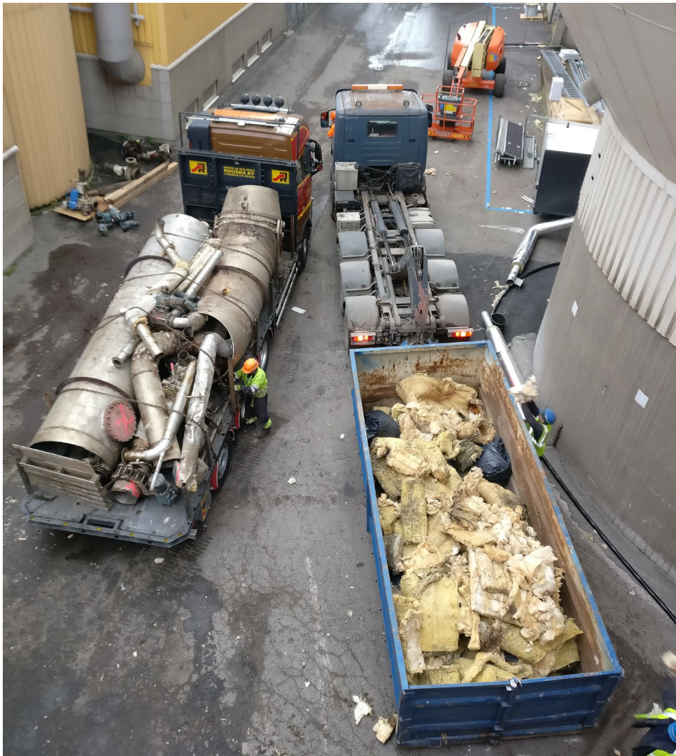
Kuvio 5. Työmaan siivoaminen vanhoista laitteista ja jätteistä on olennaisen tärkeää koko työmaan ajan alusta loppuun. Kuten kuvasta näkyy ei tilaa ole paljon ylimääräiselle tavarelle. Lisäksi jäte hankaloittaa ja vaarantaa liikumista ja lisää palokuormaa. Paperiteollisuudessa muovi on pahin, jos sitä joutuu pienikin määrä selluun, menee koko seluerä pilalle.
