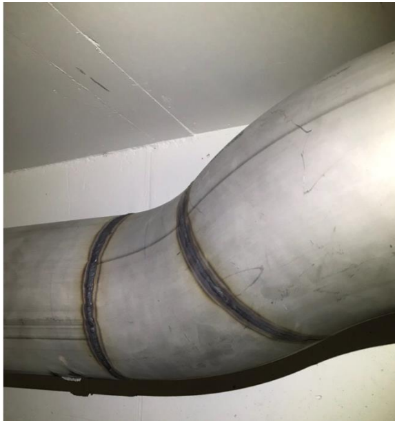
Kuva 8. Tig-hitsattu haponkestävä palovesiputki, sauma peittaamatta.
