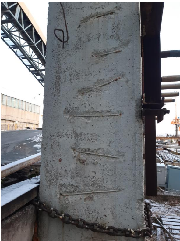
Pilari n:o 2 tyypillisenä esimerkkinä terästen suojabetonin vahvuudesta
