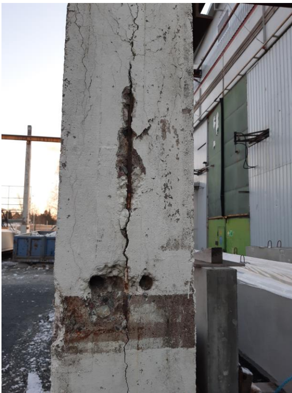
Pilarissa n:o 2 pahimmat pääterästen korroosion aiheuttamat halkeamat. Teräkset ovat osittain näkyvissä.
