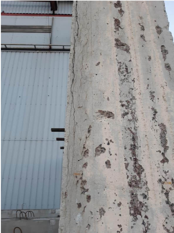
Pilarissa n:o 2 pahimmat pääterästen korroosion aiheuttamat halkeamat. Teräkset ovat osittain näkyvissä.
