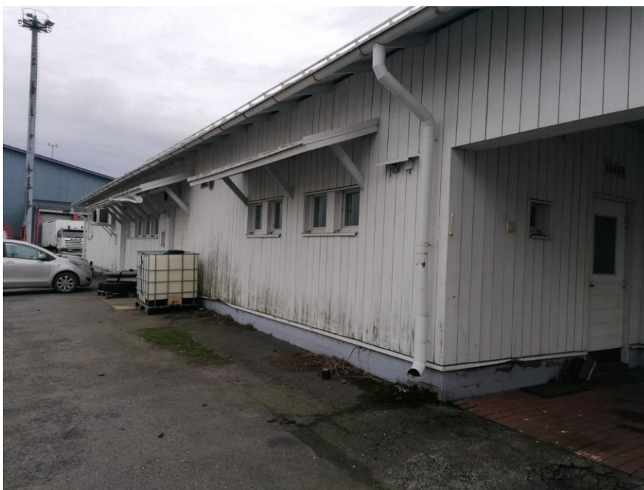
Kuva 6. Lähtevän kalan pariovi ja oikealla sosiaalitalan sisäänkäynti, yllä olevassa kuvassa esitetty julkisivu.
