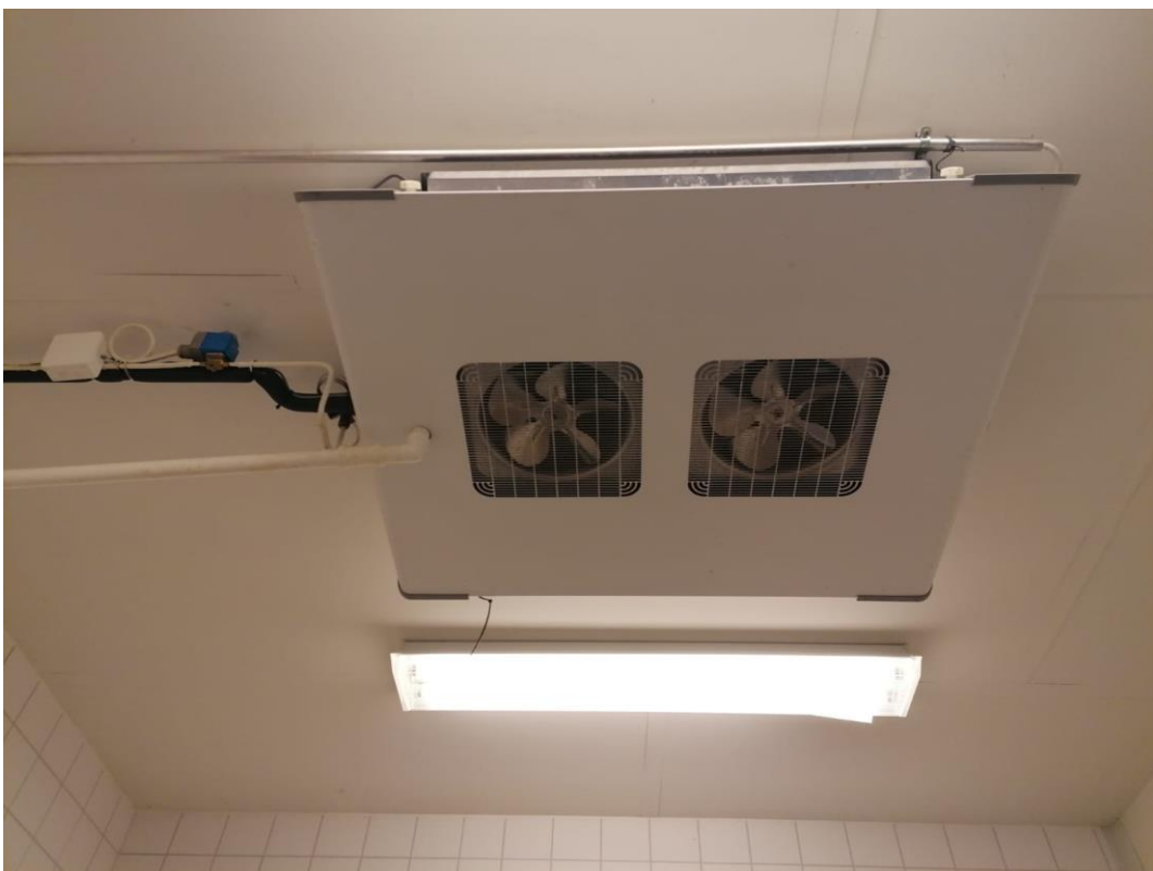
Kuva 17. Katossa oleva jäähdytyslaite.
