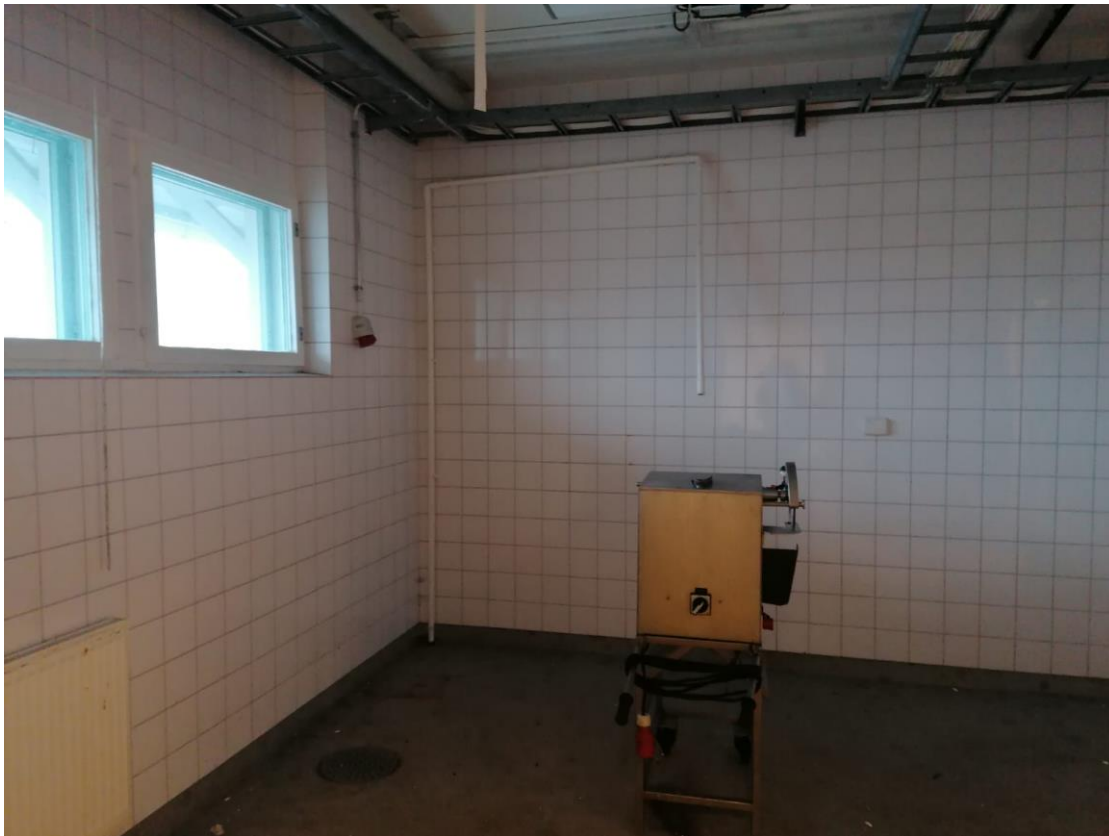
Kuva 15. Kalankäsittelytilojen seinäpinnat ovat laattaa.
