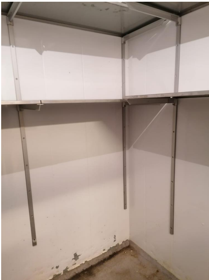
Kuva 26. Pienemmän kylmiön seinä.
