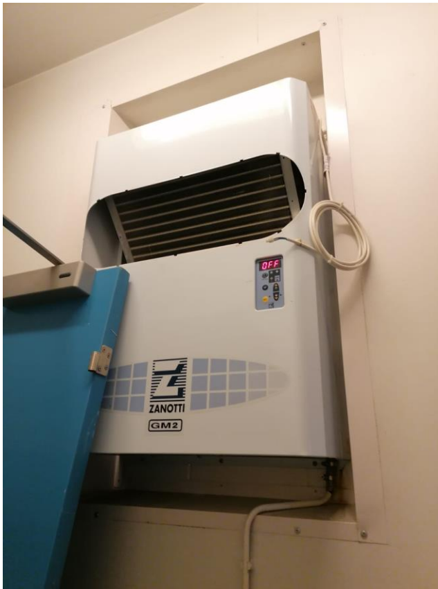
Kuva 23. Tämänhetkinen jäädytyslaite.
