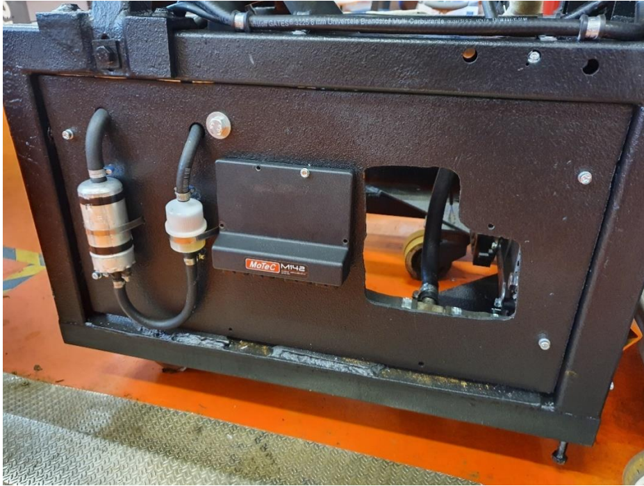
KUVA 11. Moottorikehikon sivulle asennetut toimilaitteet vasemmalta oikealle lueteltuna: polttoainepumppu, polttoainesuodatin, MoTeC M142 -moottoriohjain paikallaan havainnollistamiseksi ja valmis kiinnityspaikka sulakerasialle
