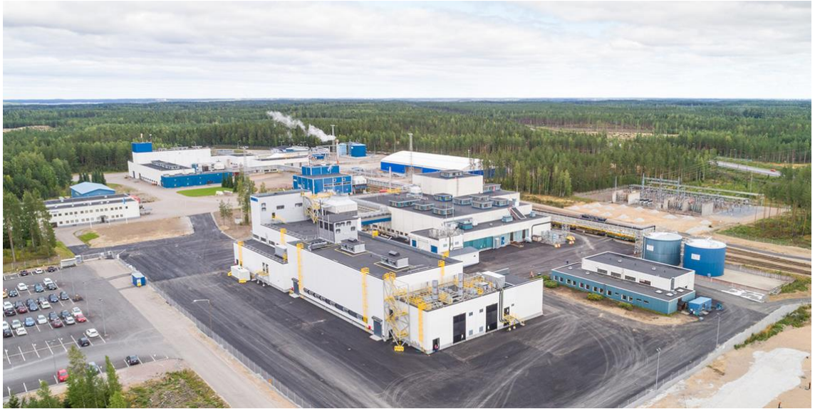
Kuva 1. Kemira Chemicals Joutseno vuonna 2017 uuden klooraattitehtaan valmistuttua (LATO)
