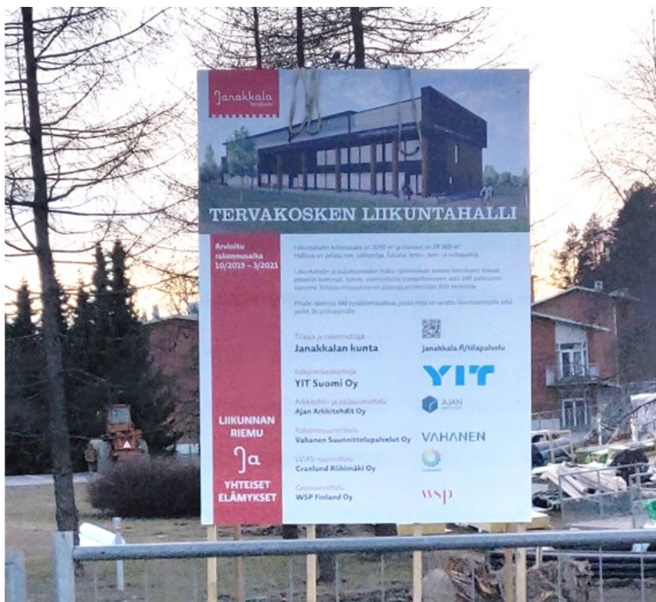
Kuva 35. Tervakosken Liikuntahallin työmaataulu (Salonen, 5.4.2020).
