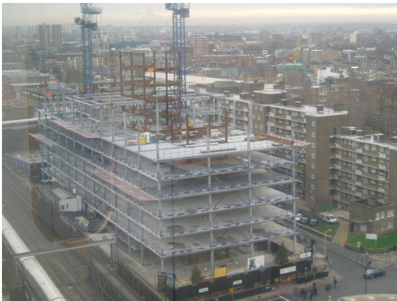
Kuva 5. Esimerkki kehäjäykistetyistä rungosta Palestra-rakennus (Allen 2006)
