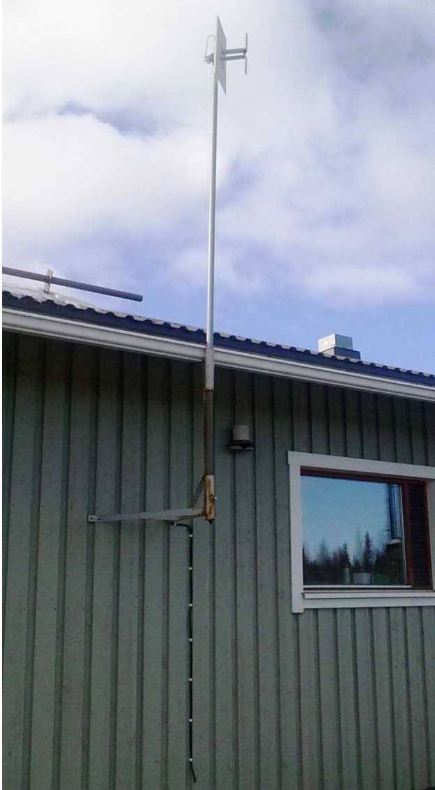
KUVA 4. Valvomon radioantenni
