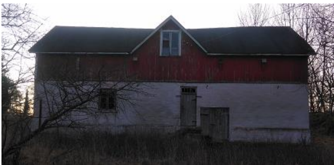
Bild 25 1241.7 Överblicksbild över fasaden mot nordöst. På bilden syns en wc dörr och porten leder till förvaringsplatsen för gödsel. Genom porten tog man ut gödsel och förde ut till de närliggande åkrarna.
