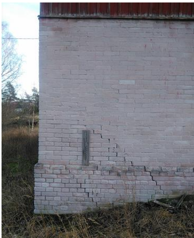
Bild 14 1232a.6 På bilden det norra hörnet, murad delvis på berg och överlag i en bättre kondition än övriga fasader, stenarna är slitna och murbruket har lossnat på ställen men inga större sprickor i teglen.
