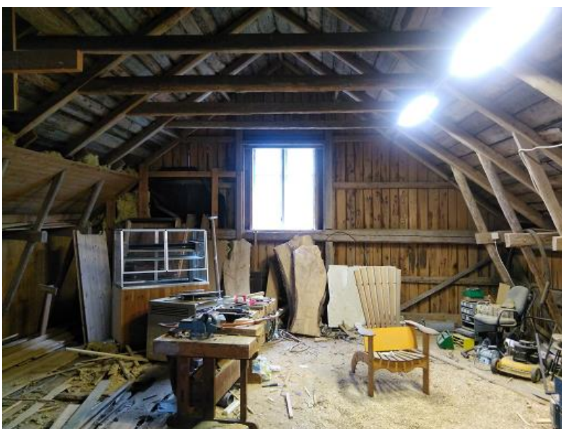
Bild 27 1261.2 Överblicksbild över höförrådet, bilden tagen mot riktning sydöst. Denna del används som snickarverkstad. Man kan se att väggen till vänster är delvis isolerad och iklädd innerpanel.
