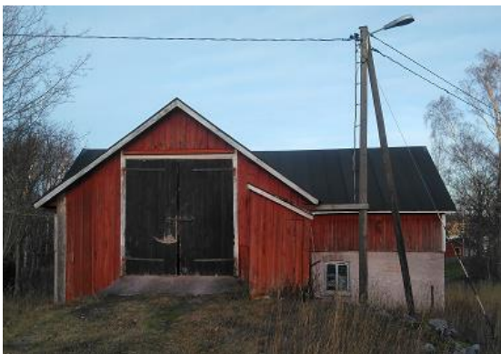
Bild 22 1241.4 Överblicksbild över fasaden mot sydväst. Porten leder till hövinden. Ingången har i något skede blivit tillbyggd. Det lilla utstickande tillbyggnaden till höger om porten verkar ha kommit till i ett ännu senare skede.
