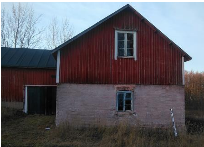
Bild 24 1241.6 Överblicksbild över fasaden mot sydöst. Till vänster porten till ladugården och på höger sida kan man se det östra hörnet som har stötts upp. På bilden syns också ett anteckningsblock och ett vattenpass.
