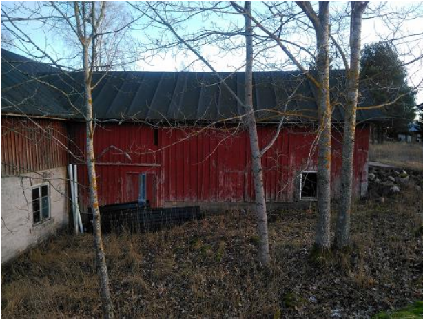
Bild 1 1116.1 Marken sluttar mot husgrunden.
