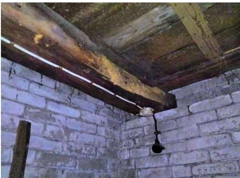
Bild 18 1232b.4 På bilden ser man mellanbjälklaget och golvet. Bilden är tagen var höluckan tidigare fanns och man kan se slitage på bjälken från det. Bjälken var något fuktig på ytan.
