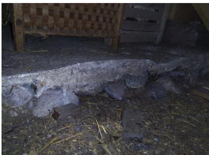
Bild 2 1211.1 Märk den smala golvplattan och utfyllnadsstenar.
