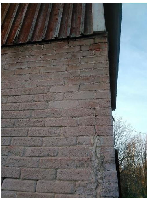
Bild 10 1232a.2 Bild från det östra hörnet, fortsättningen på sprickan i bild 8 .
