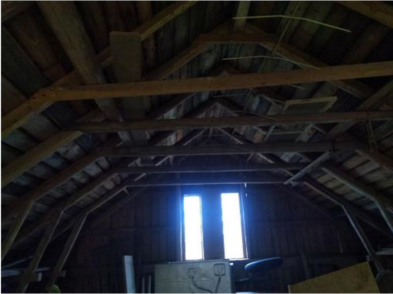
Bild 28 1261.3 Överblicksbild över höförrådet, bilden tagen mot riktning nordväst. Denna del används som förrådsplats. Övrebjälklaget och takstolarna i god kondition.
