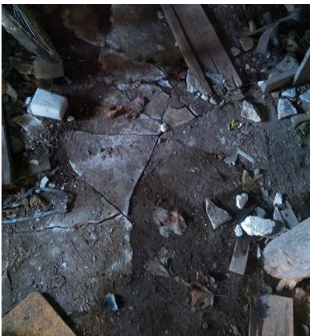
Bild 3 1211.2 Sprucken golvplatta.
