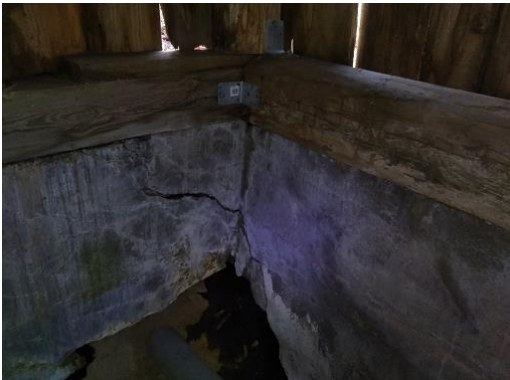
Bild 8 1212.4 Spricka i den gjutna sockeln, man kan även se vatten sippra in under grunden.
