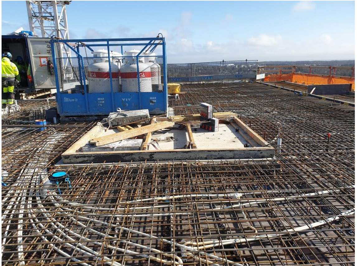
Kuva 10. Raudoitettu paikallavalettava välipohja
