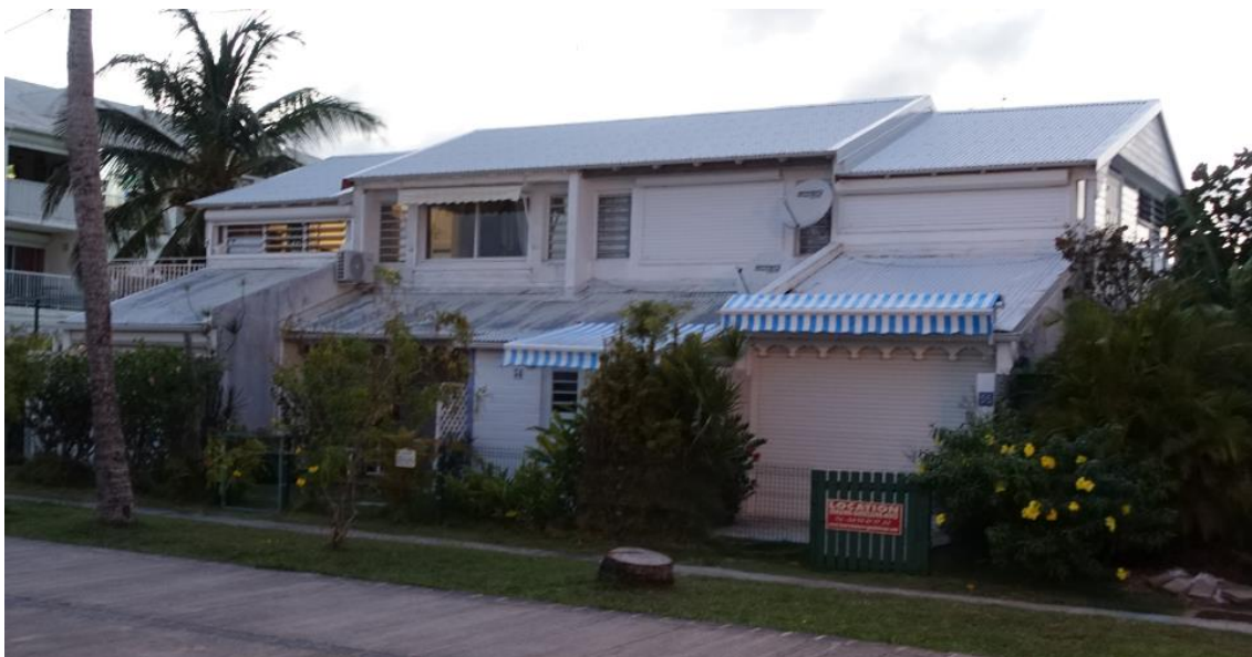
Kuva 10. Pientalon ulkopuolinen aurinkosuojaus.
