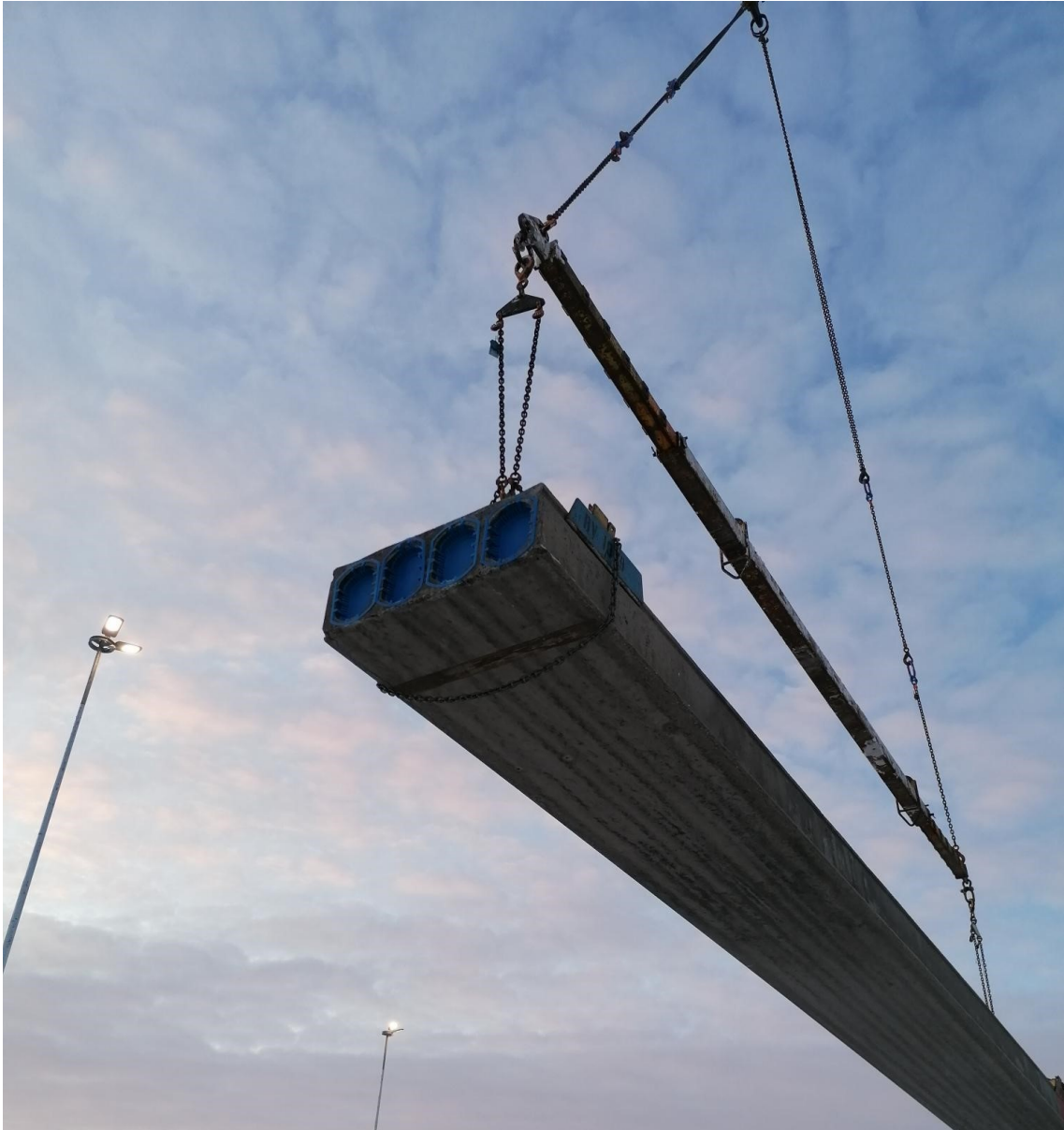
KUVA 5. Ontelolaatan nosto varmuusketjullisilla nostosaksilla
