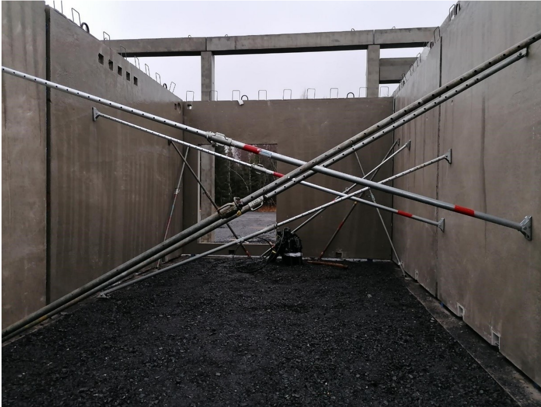
KUVA 4. Seinäelementit tuettu elementtitiulla
