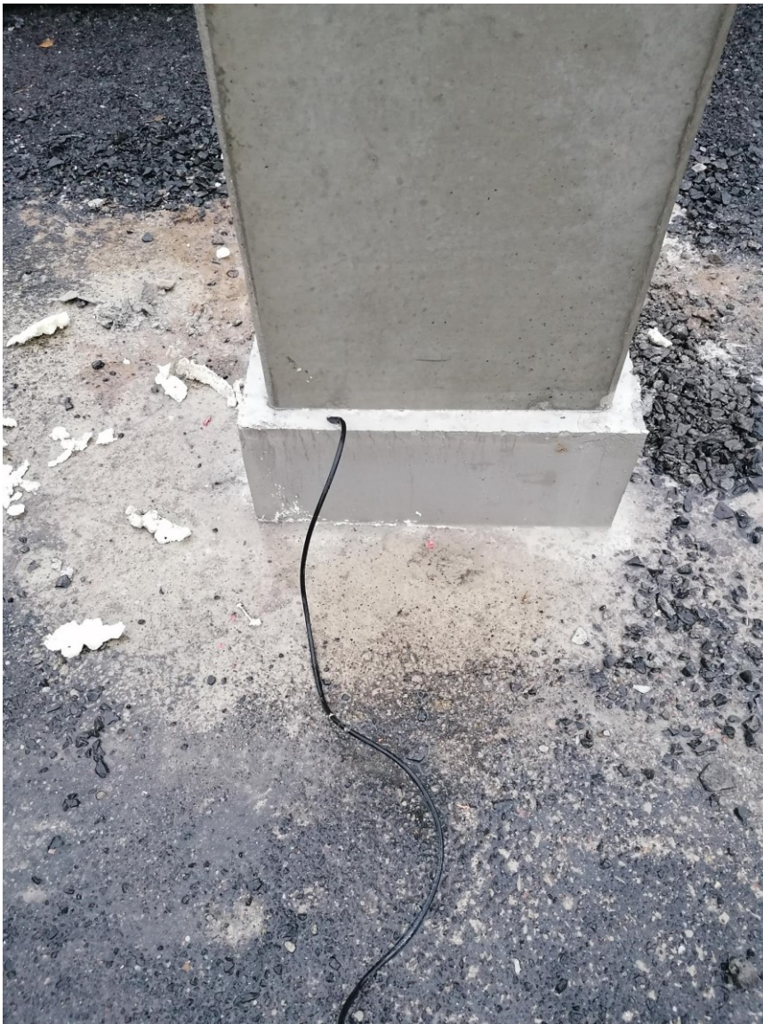
KUVA 2. Pilarin juuri valettu juotosbetonilla
