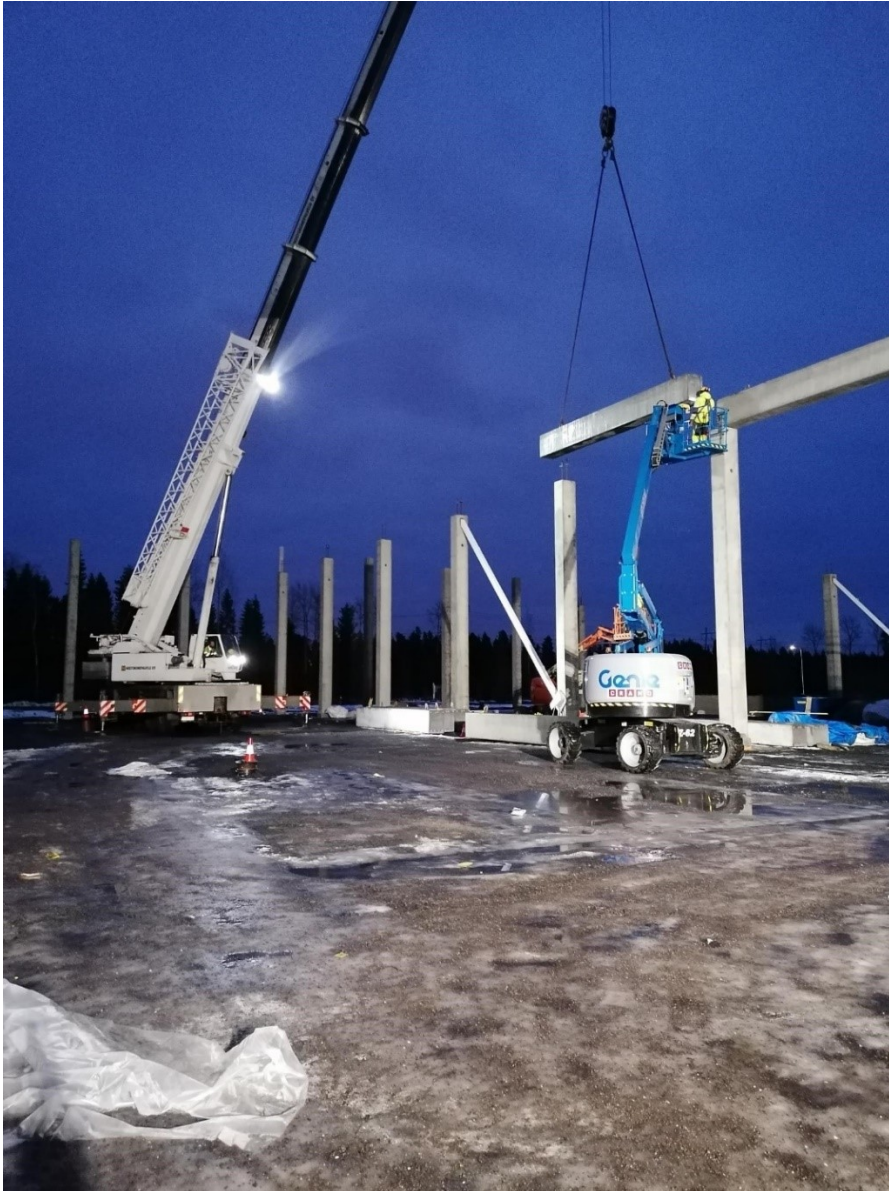
KUVA 3. Palkin asennus kuukulkijoista
