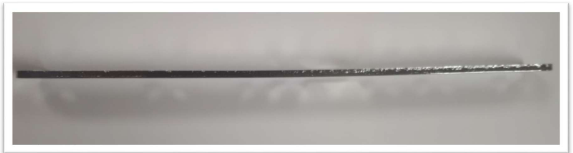
Kuva 13. Vääntynyt rintalevy [Kuva: Saukkonen 2019].
