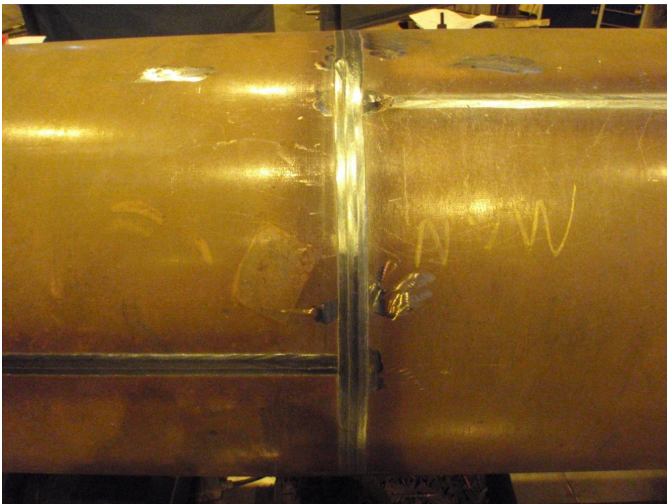
KUVA 29. SAW- hitsauksen jälkeen.
