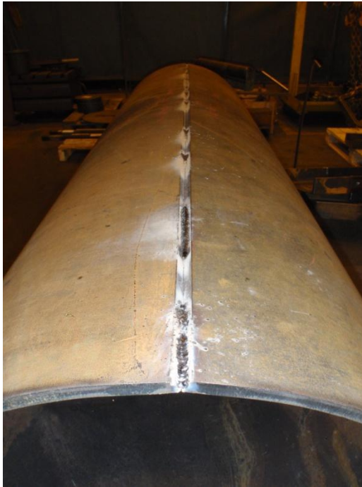
KUVA 27. Yksi putkista mankelointivaiheessa.
