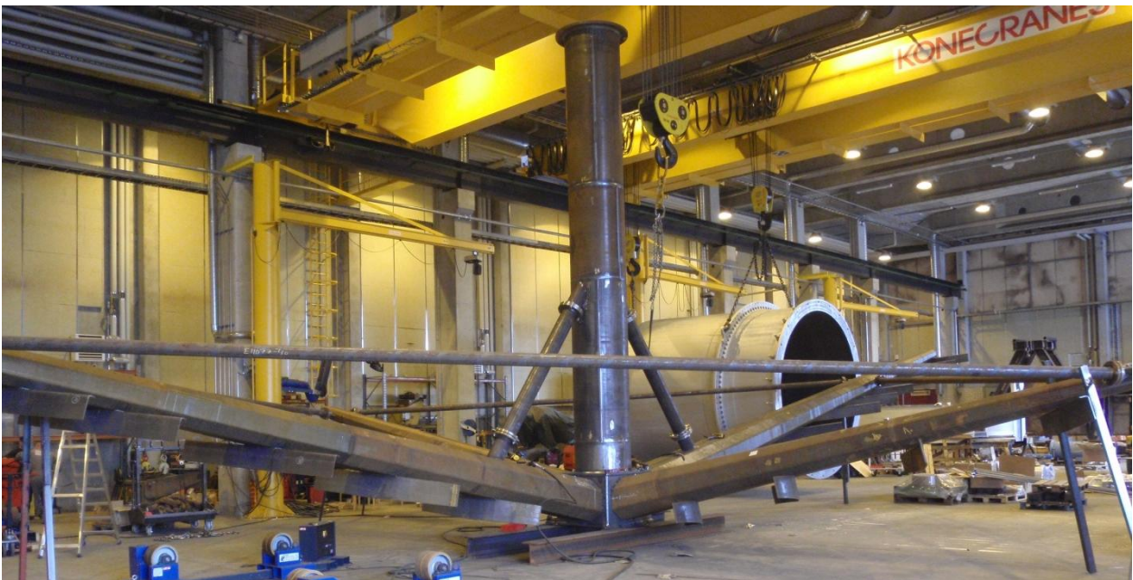
KUVA 32. Sakeuttimen hara koekasattuna. Kun osat sovitettiin ne merkittiin ja purettiin pintakäsittelyä ja pakkausta varten.
