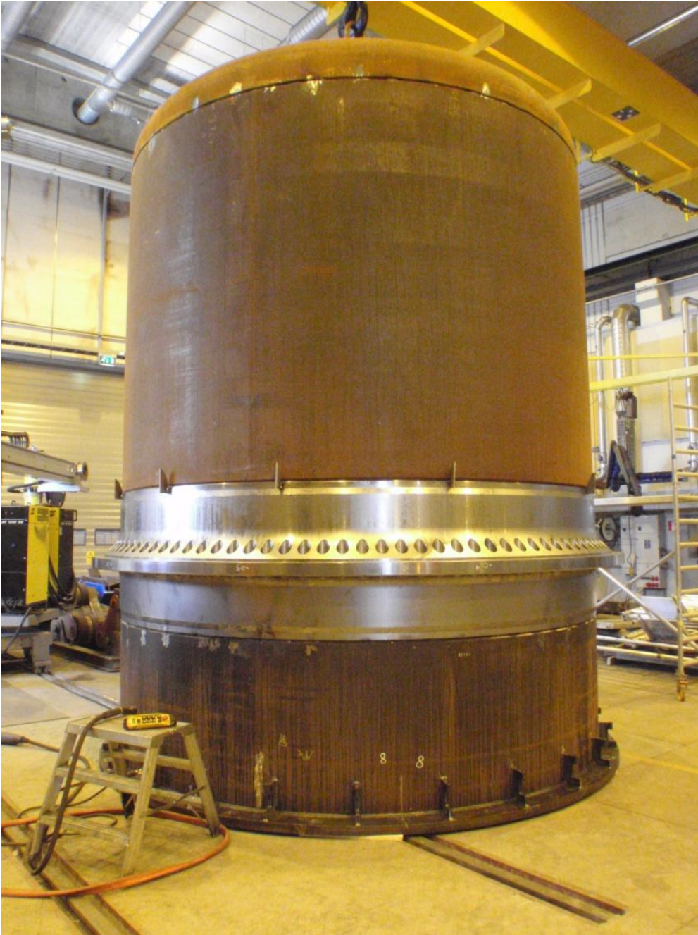
KUVA 23. Big Kaldo liitettynä. Kehähitsit (3kpl) hitsattiin SAW:lla molemmin puolin x-railona.
