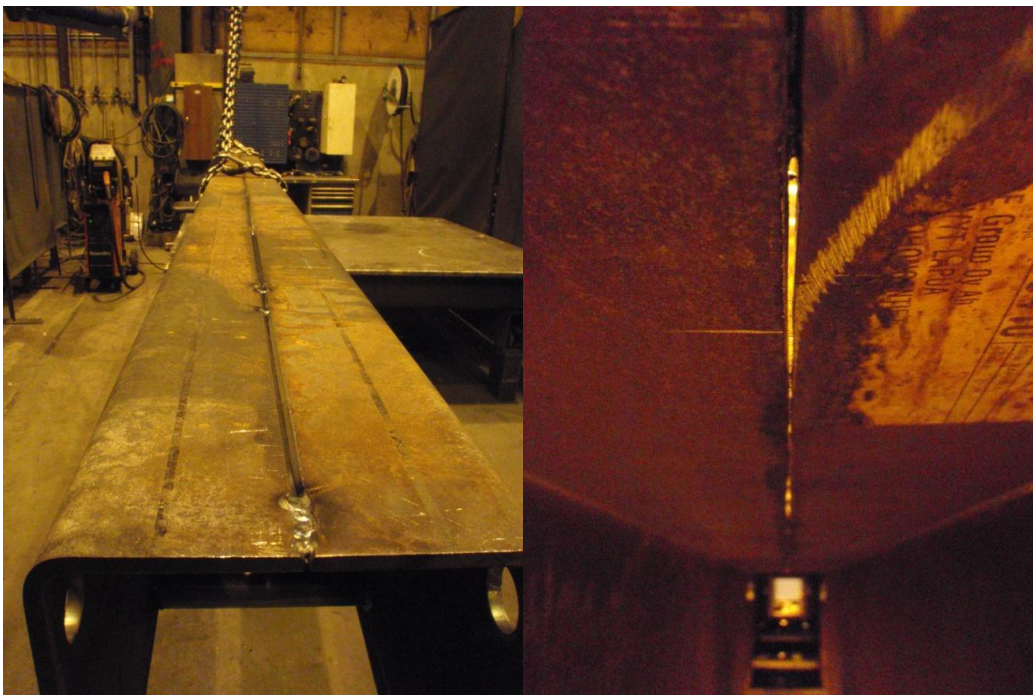
KUVA 25 ja 26. Silloitettu nostopalkki ennen hitsausta.
