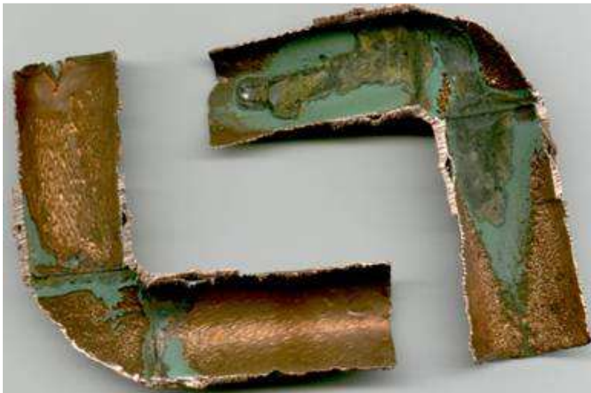
Kuva 4. Eroosiokorroosio kupariputken mutkassa (Corrosion Control 2009).
