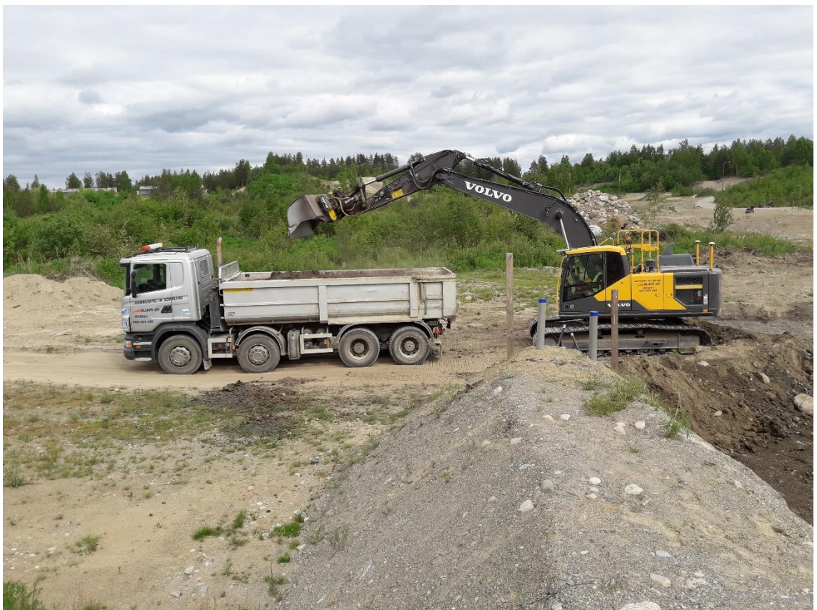
Kuva 3. Kaivinkone ja kuorma-auto
