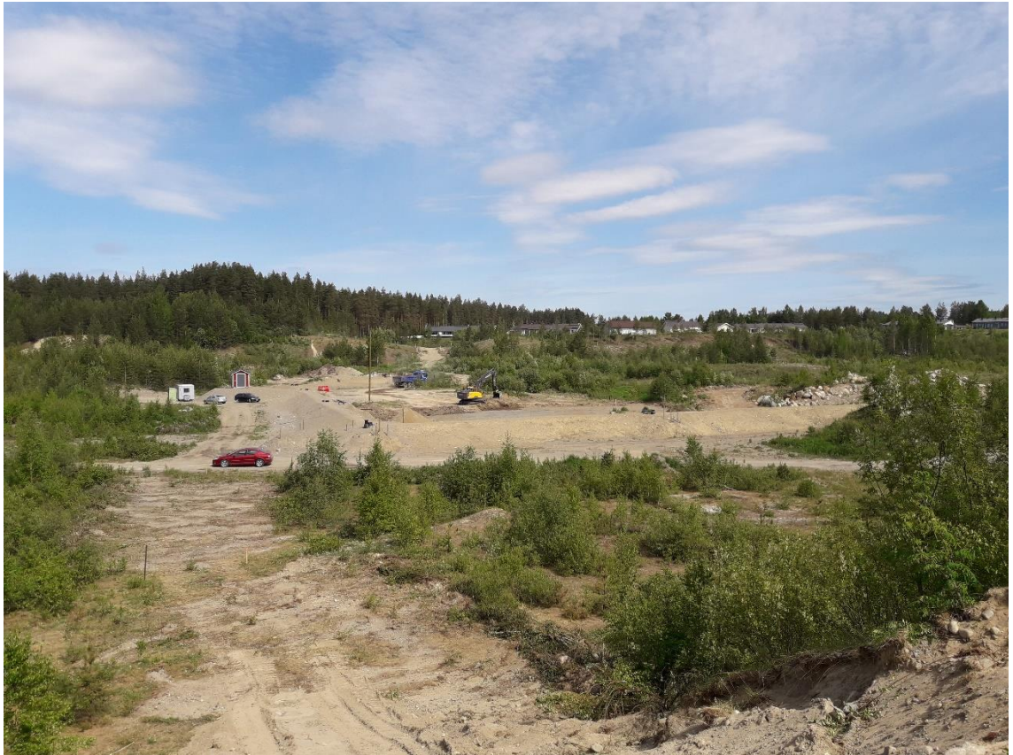
Kuva 1. Työmaa kuvattuna eteläpuolen harjulta
