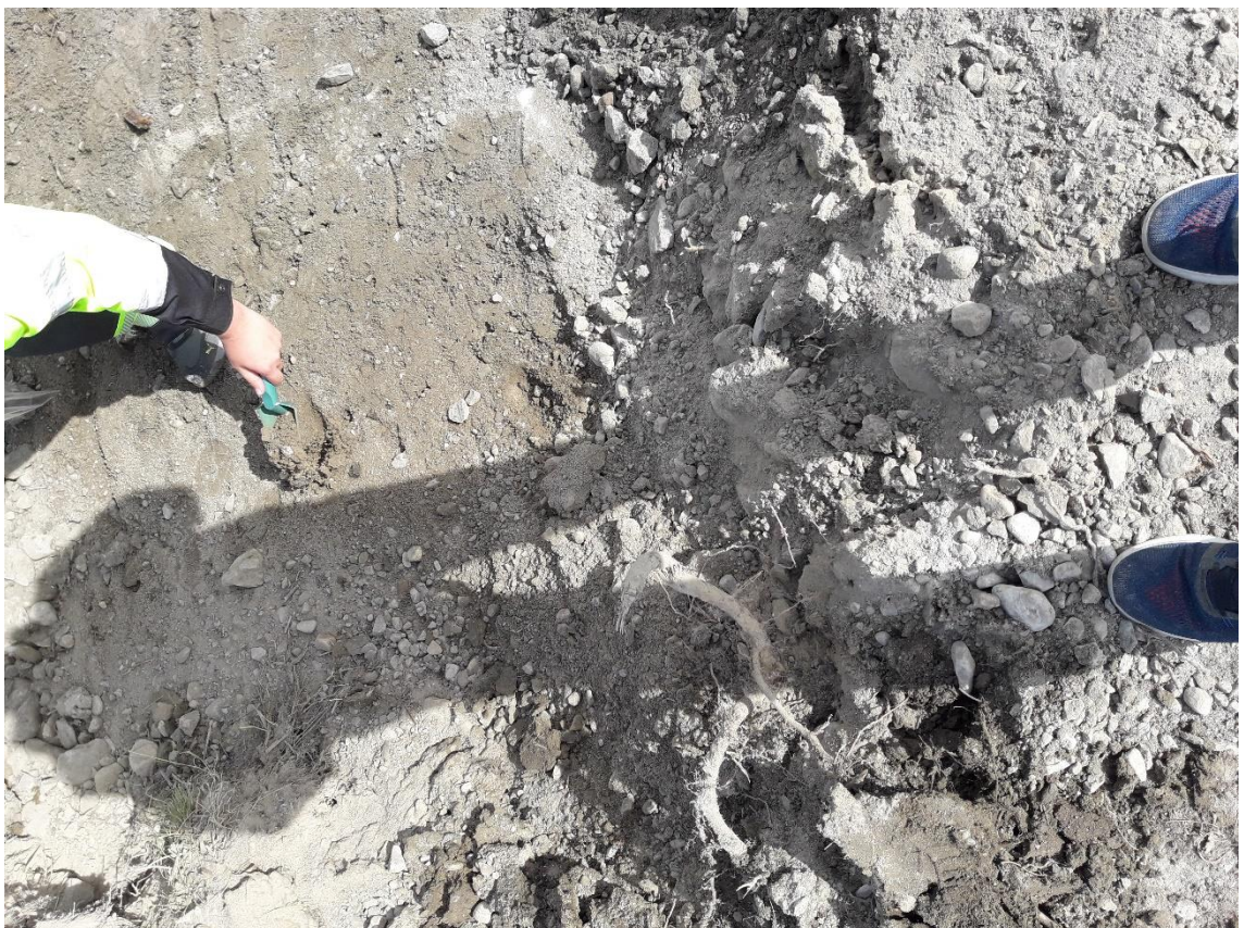
Kuva 7. Näytteen ottoa kaivannosta
