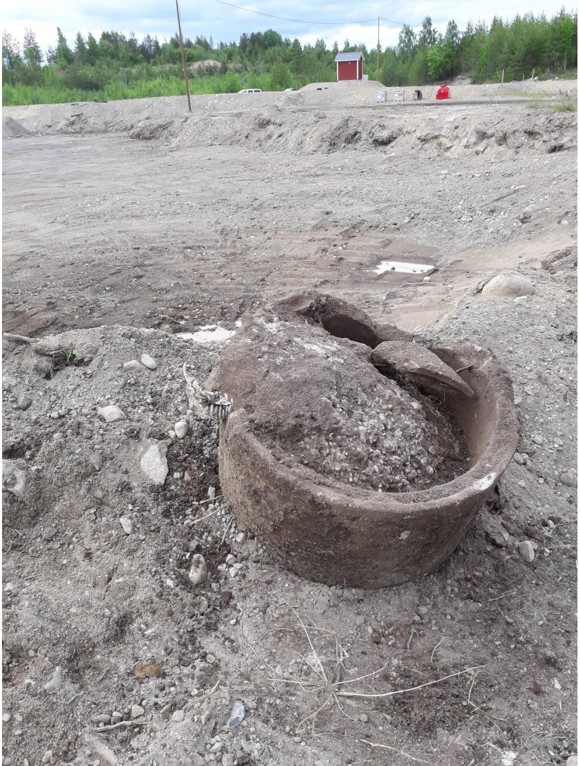
Kuva 8. Kaivannosta löytynyt betoninen kaivonrengas
