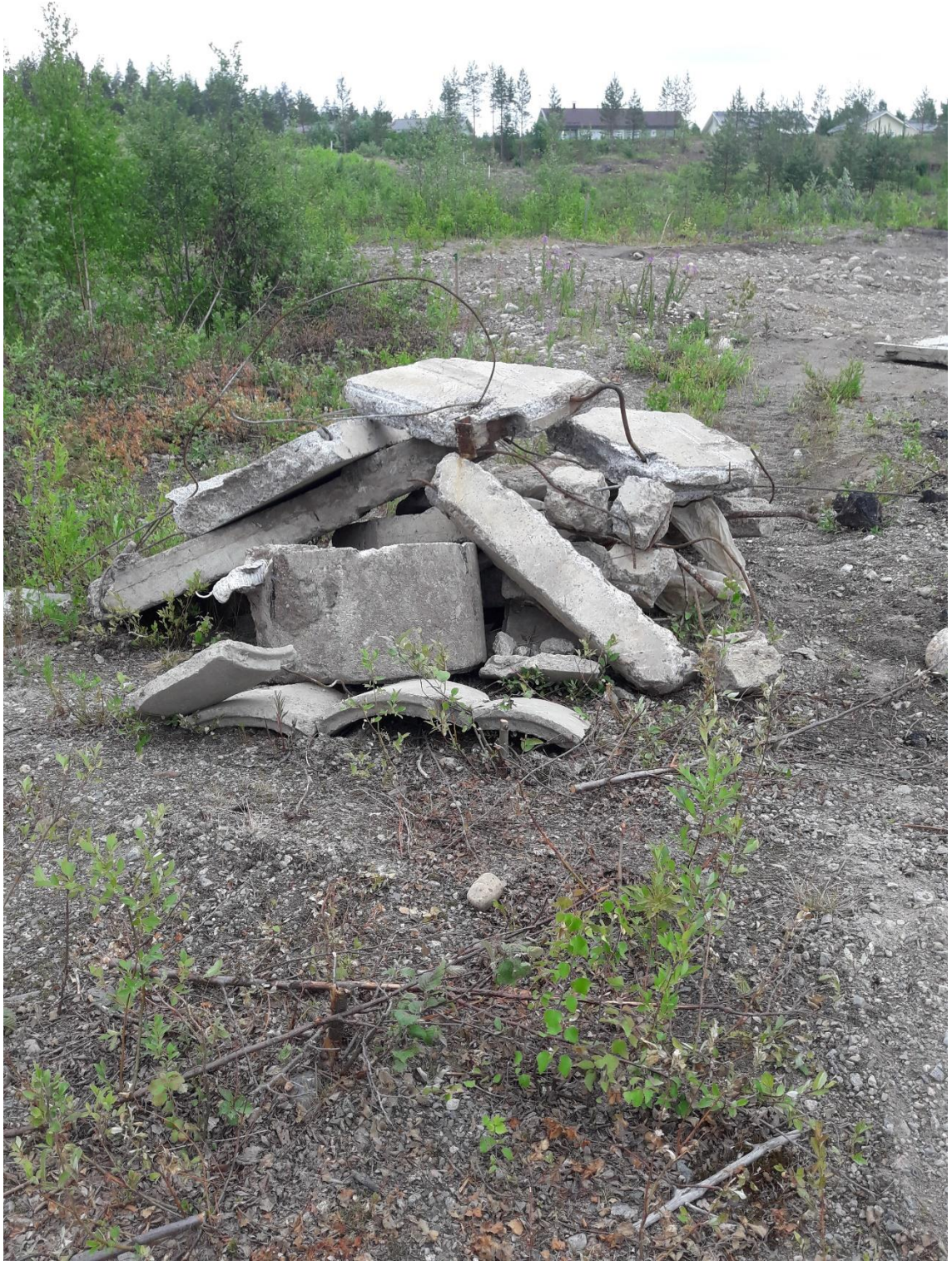
Kuva 12. Kaivannosta löytynyttä teräsbetoni jätettä
