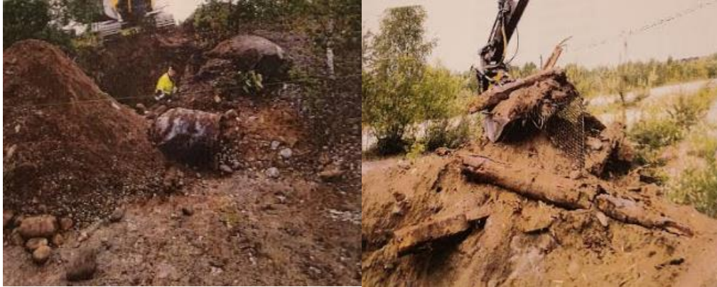
Kuva 6. Maaperään on haudattu mm. vanhoja tynnyreitä ja metallia ja suuria puuparruja (Kuva: Elinkeino, liikenne- ja ympäristökeskus 2011.)
