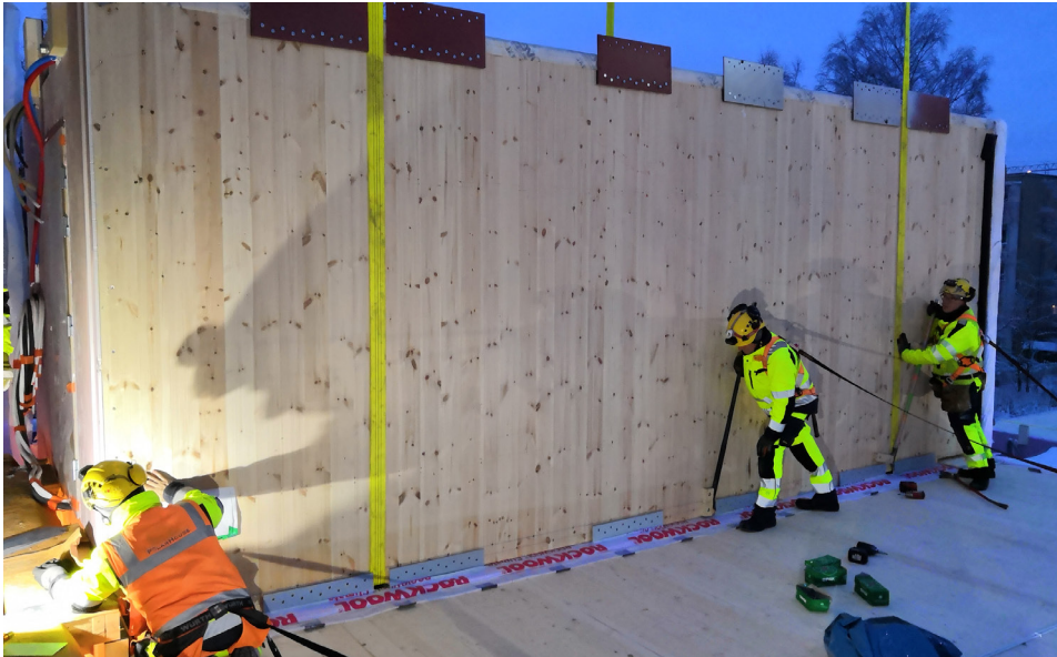
Kuva 6. CLT-tilaelementin asennustyö on millintarkkaa työtä
