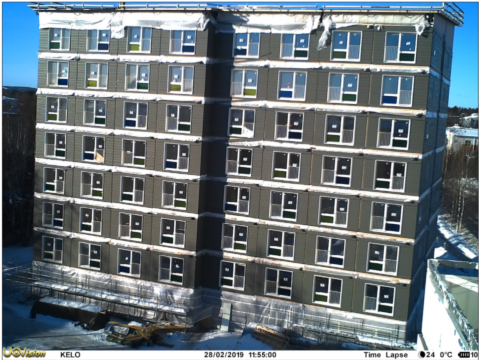
Kuva 14. DAS Kelon 8. kerroksen tilaelementit asennettu
