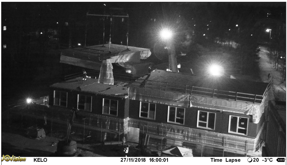
Kuva 5. DAS Kelon vesikattoelementtien hyödyntäminen työmaan aikaisessa sääsuojauksessa
