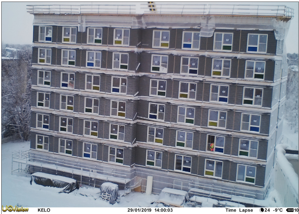
Kuva 13. DAS Kelon 7. kerroksen tilaelementit asennettu
