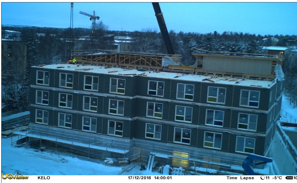
Kuva 10. DAS Kelon 4. kerroksen tilaelementit asennettu
