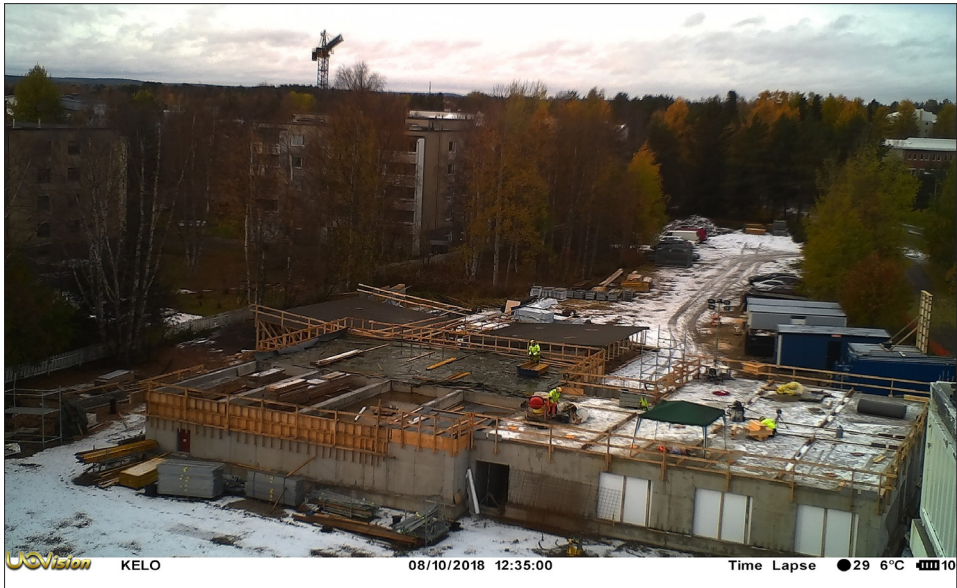
Kuva 2. Vesikattoelementtien valmistus käynnissä
