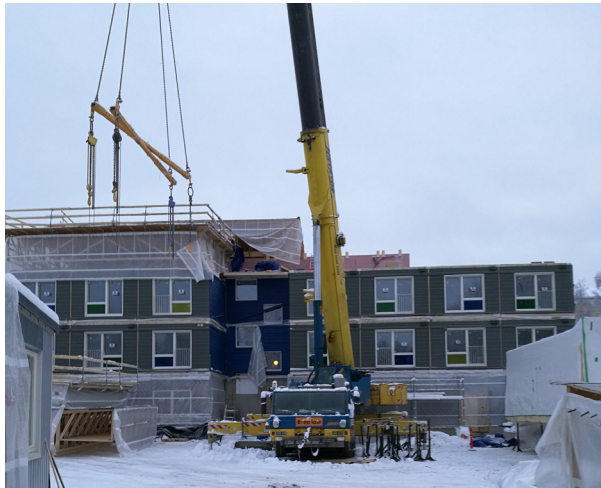
Kuva 4. DAS Kelon vesikattoelementtien hyödyntäminen rakentamisen aikaisessa sääsuojauksessa (Domus Arctica -säätio 2019)
