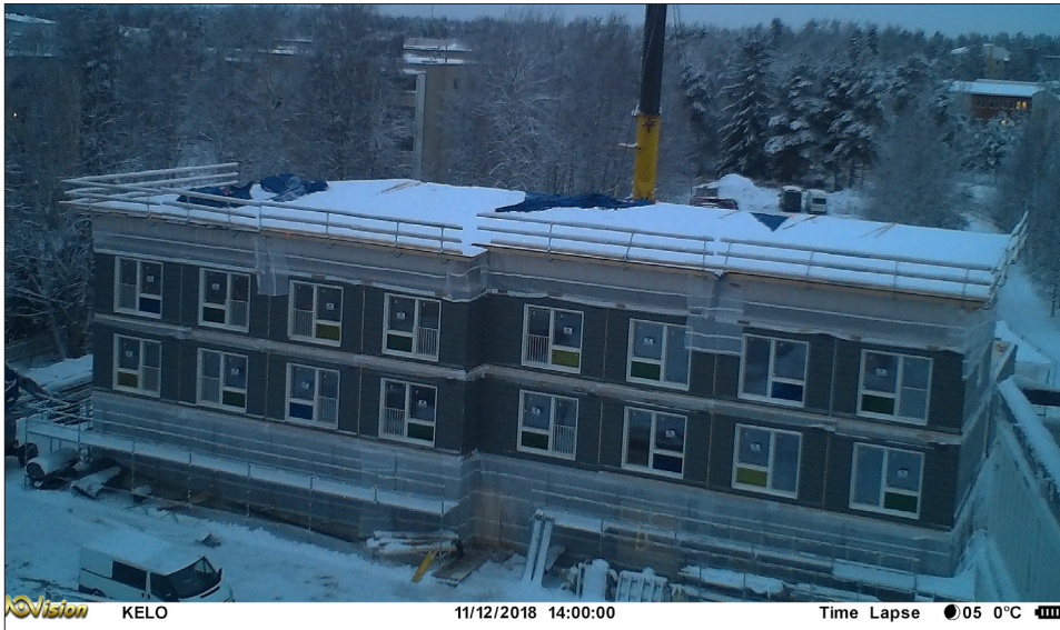
Kuva 9. DAS Kelon 3. kerroksen tilaelementit asennettu
