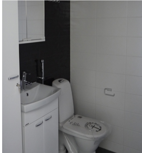
Kuva 3. Kylpyhuone-elementin varustelua (Domus Arctica -säätio 2019)
