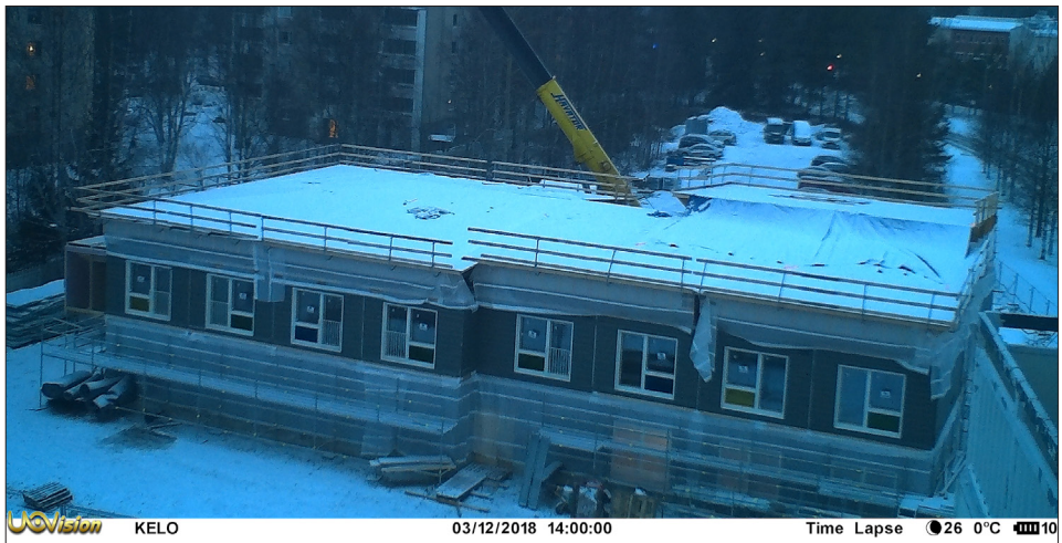
Kuva 7. DAS Kelon 2. kerrokset tilaelementit asennettu
