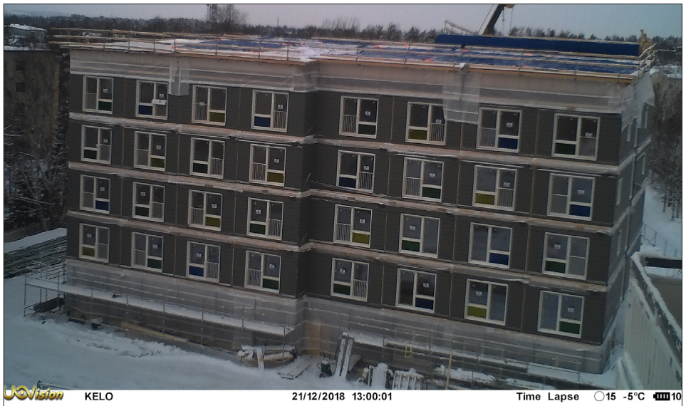
Kuva 11. DAS Kelon 5. kerroksen tilaelementit asennettu
