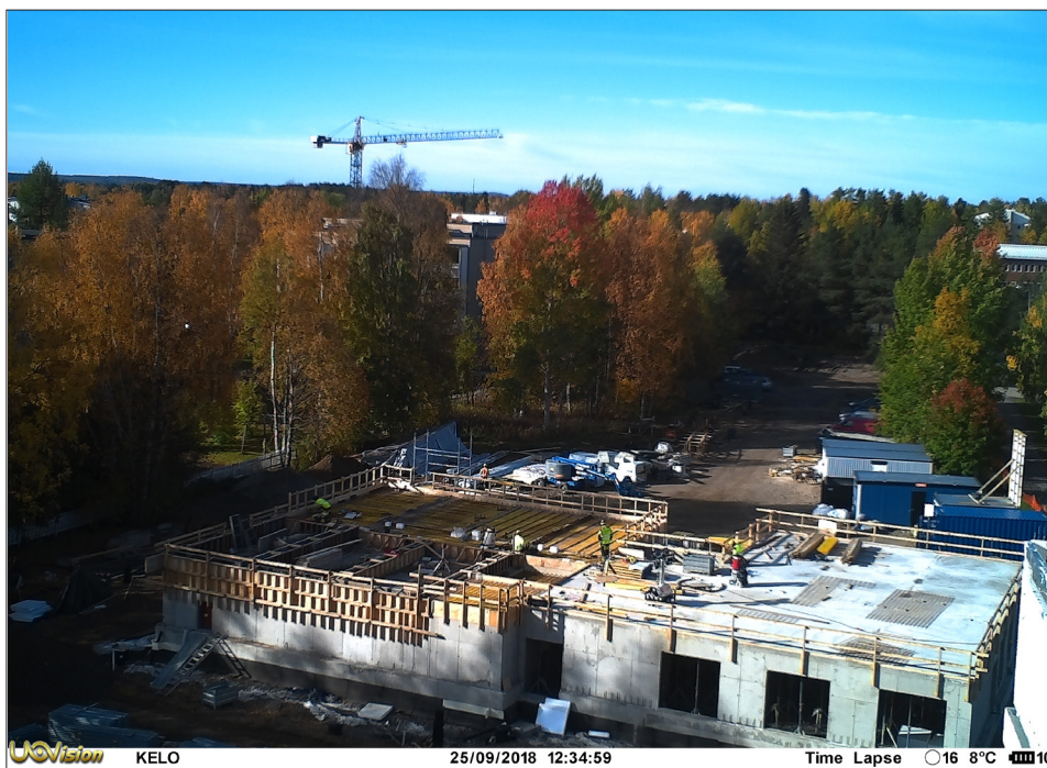
Kuva 1. DAS Kelon 1. betoninen kerros valmiina ennen tilaelementtien asennustöiden aloittamista
