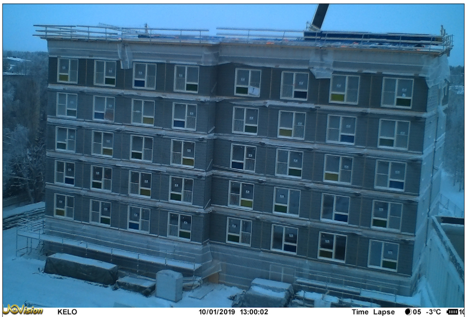
Kuva 12. DAS Kelon 6. kerroksen tilaelementit asennettu
