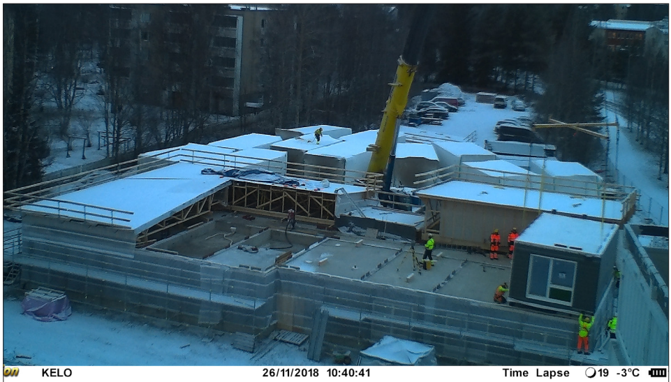
Kuva 4. DAS Kelo 2. kerroksen ensimmäisen tilaelementin asennus
