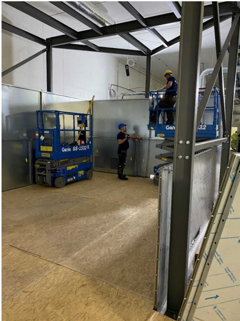
Kuvio 16. EMC-testihuoneen seinäpaneelien asennus
